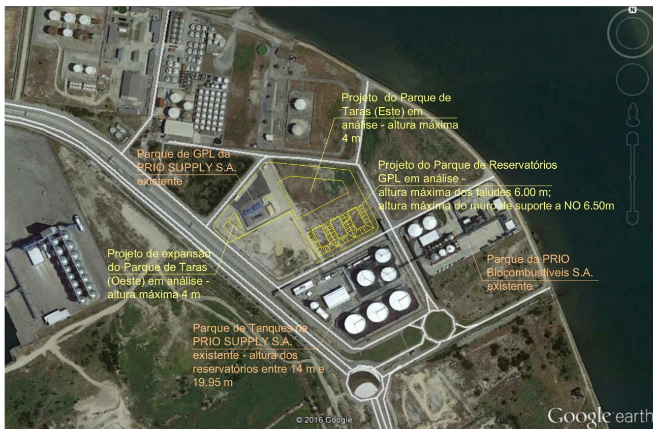
Figura C.39 – Vista Aérea da zona de implantação do projeto, no Terminal de Granéis Líquidos. Localização e identificação das instalações existentes da PRIO e sua relação com os elementos de projeto.
