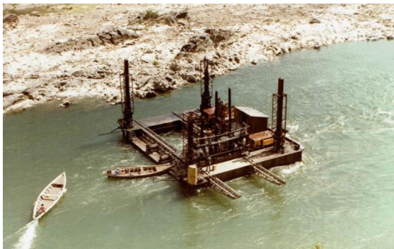
Fotografia 7 – Exemplo de plataforma flutuante para torres perfuradoras
