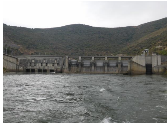
Fotografia 2 – Barragem da Valeira, no extremo de montante da área de intervenção (Pk 144+663)
