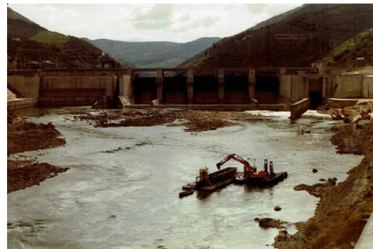
Fotografia 8 – Exemplo de plataforma flutuante com escavadora
