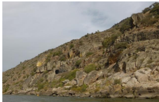
Fotografia 10 – Afloramentos graníticos na margem direita do rio Douro (túnel da Rapa ~ Pk 140+100)
