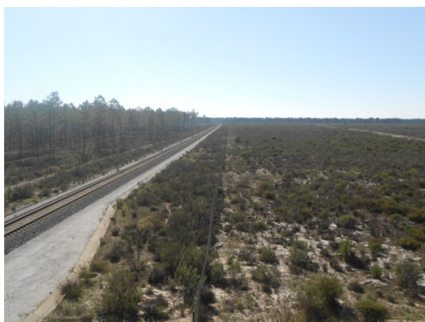
Fotografia 5.12 – Vista sobre a linha ferroviária do sul que limita a propriedade a nascente
