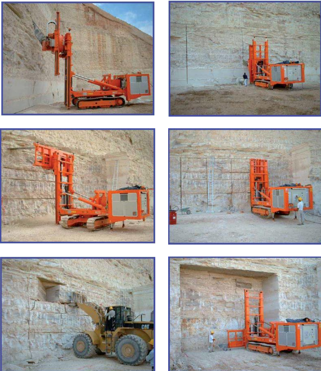
Figura 14- Imagens com a sequência de traçagem e início abertura de galeria piloto (Adaptado do catálogo geral da marca Fantini ).
