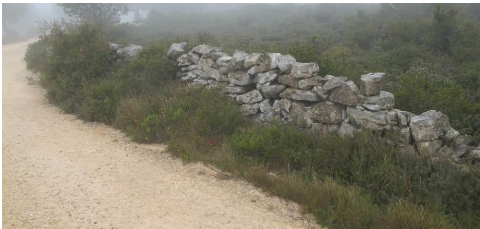
Figura 106 – Vista parcial do muro de pedra seca – Covão do Tojal.
