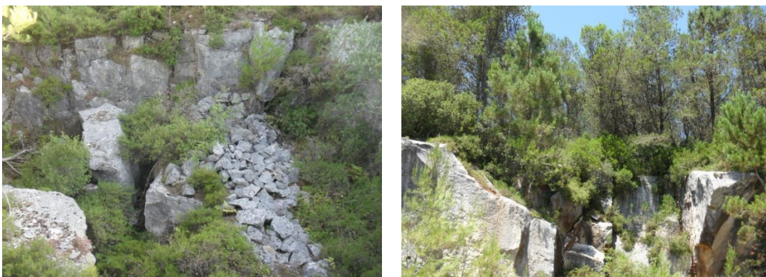
Figura 64 - À esquerda: acumulação de rochas onde é possível a existência de uma cavidade actualmente obstruída à esquerda. À direita: antiga zona de exploração com fissuras.
