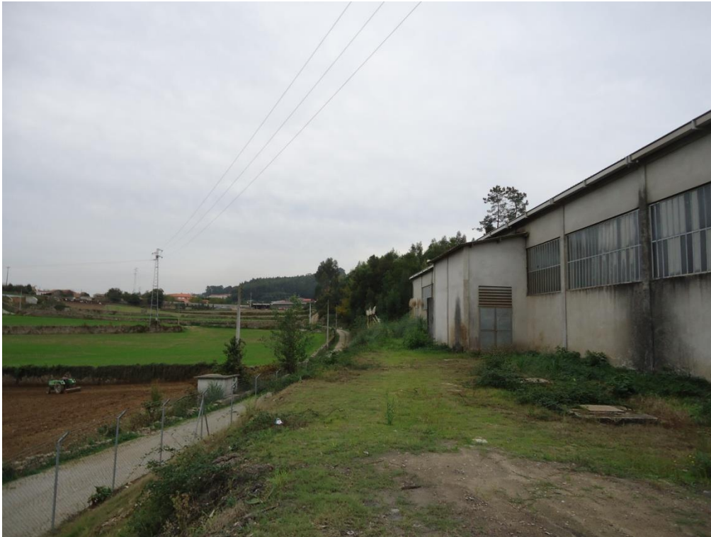
Figura 74 - Visibilidade do Solo – Aterro e Escavações.
