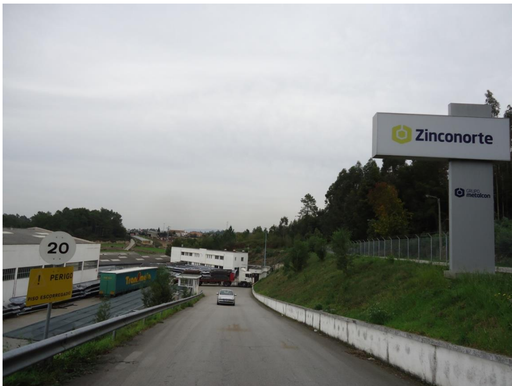
Figura 75 - Visibilidade do Solo – Aterro e Escavações.
