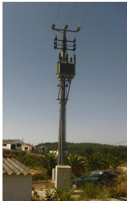
Figura 19 - Posto de transformação existente na exploração
