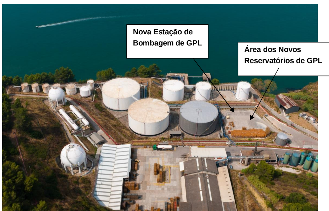
Figura 2 - Alterações previstas na instalação
