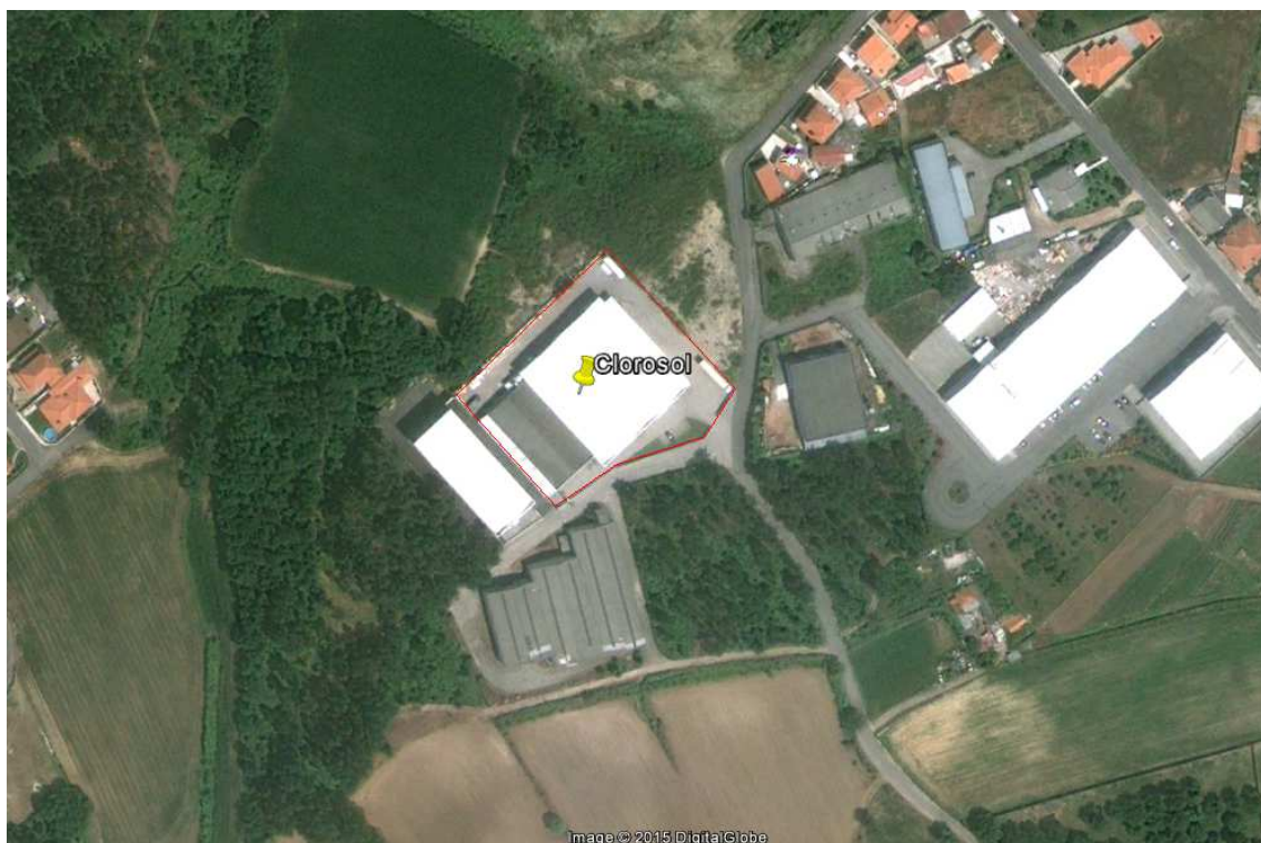
Figura 2.10- CLOROSOL em agosto de 2010 após ampliação do edifício anterior (imagem do Google Earth).
