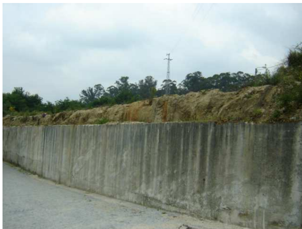
Figura 2.11- Área no topo Nordeste do lote que foi alvo de escavação e respetivo muro de contenção.
