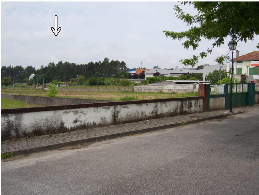
Figura 4.6 – Vista da CLOROSOL a partir do ponto de observação 42 identificado na Figura 4.3 (ponto a nascente da Clorosol).
