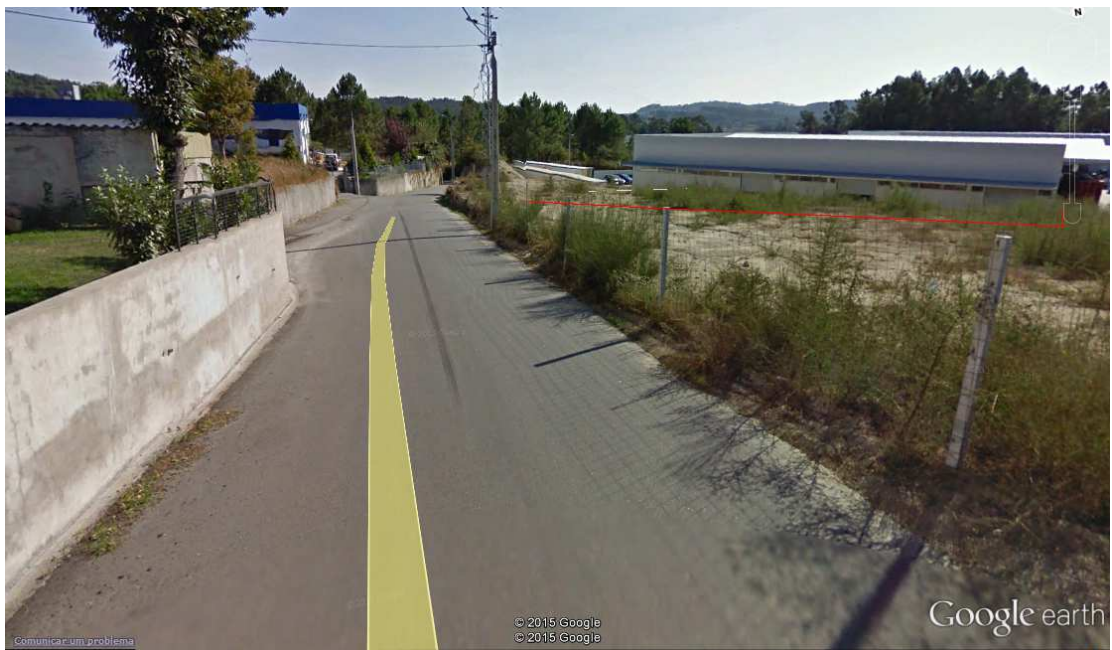
Figura 3.66 – Perfil da rua da industria nas proximidades da CLOROSOL (acesso por norte).
