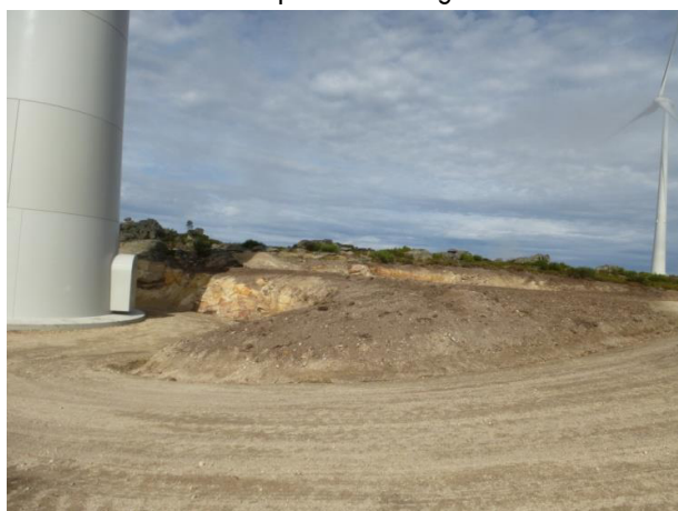
Exemplo da recuperação ambiental dos taludes junto ao aerogerador e ao longo do caminho de acesso
