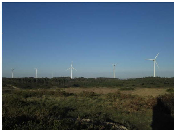
Aerogeradores do Parque Eólico de Serra d'El Rei
