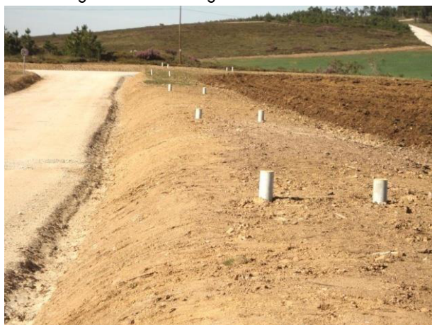
Exemplo da recuperação da zona adjacente ao caminho após o enterramento dos cabos, com pinos para indicação do trajeto da vala de cabos
