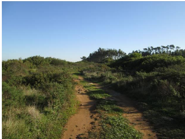
Vista para o local de beneficiação do caminho existente de acesso ao AG14 do Sobreequipamento
