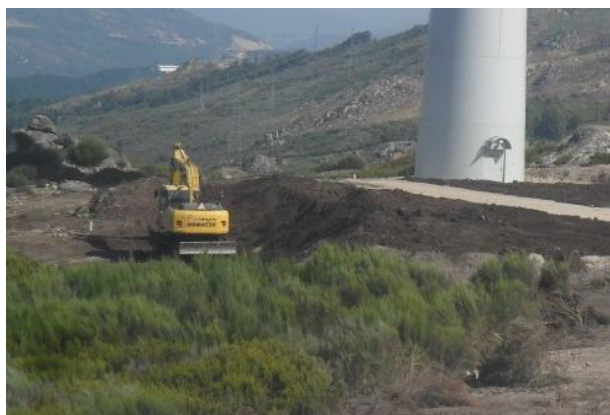
Trabalhos de regularização de taludes e recuperação ambiental junto ao aerogerador
