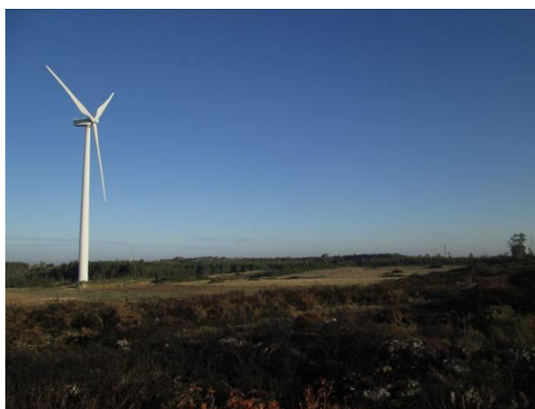
Zona atravessada pelo novo acesso e vala de cabos a partir do Aerogerador existente AG13 do Parque Eólico de Serra d'El Rei que se liga ao AG15 do Sobreequipamento
