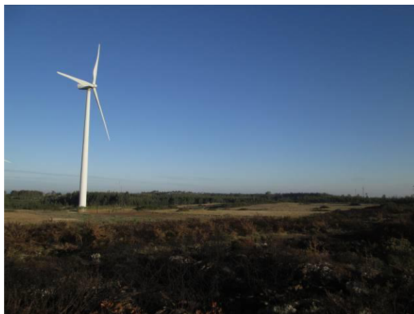
Aerogerador AG13 do Parque Eólico de Serra d'El Rei onde será ligado o AG15 do Sobreequipamento
