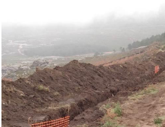
Exemplo de separação e armazenamento de terra vegetal ao longo de uma vala
