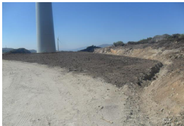
Recuperação ambiental com modelação de taludes e recuperação da plataforma
