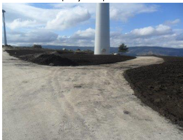
Exemplo da recuperação ambiental dos taludes junto ao aerogerador e ao longo do caminho de acesso
