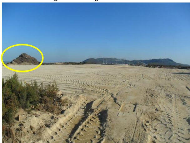
Exemplo de separação e armazenamento de terra vegetal
