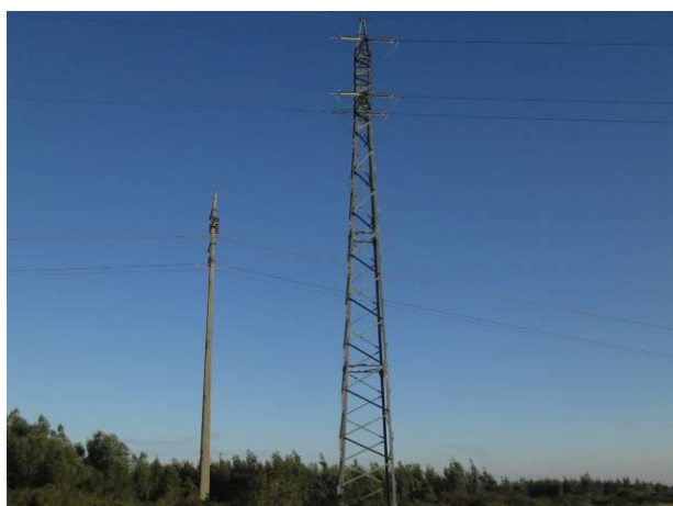
Apoios de Linhas Elétricas próximos do local do AG15 do Sobreequipamento
