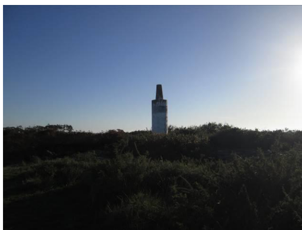
Marco Geodésico de Cesaredas próximo do local da área de estudo restrita do AG15 do Sobreequipamento
