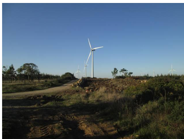
Vista para o local de beneficiação do caminho existente e vala de cabos de acesso ao AG15 do Sobreequipamento
