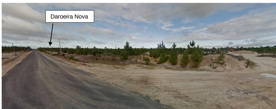
Figura 6.14.4 – Vista da área intervencionada da exploração “Daroeira”.
