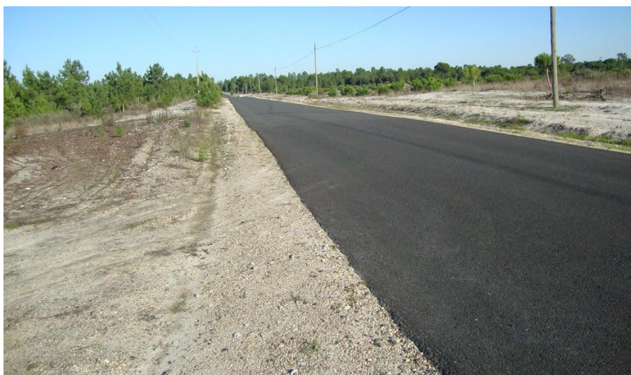
Figuras 5.11.4 e 5.11.5 – Aspeto do caminho em betuminoso que permite o acesso à futura pedreira “Daroeira Nova”.
