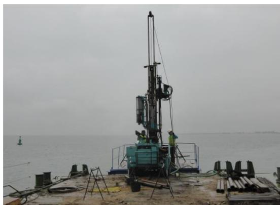
*Figura 12 – Amostragem de sedimentos em profundidade*
