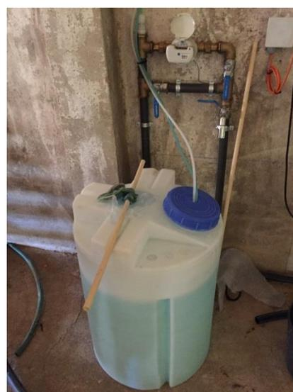
**Figura 4.5** – Sistema de pré-tratamento da água de abeberamento das aves
