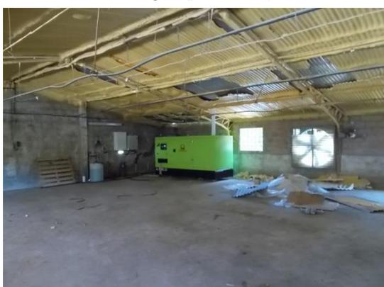
**Figura 4.6** – Gerador da instalação (para funcionamento em situações de emergência)
