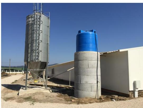
**Figura 4.4** – Silos de armazenamento da ração e depósito de água (pavilhão 1)
