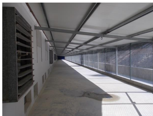
Figura 3.4 – Área exterior / parque de recreio para as galinhas poedeiras no solo – pavilhão 1
