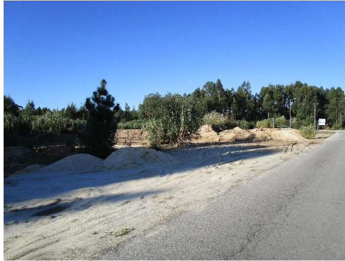
Figura 67 – Vista geral do terreno (parcela escavada e com aterros)
