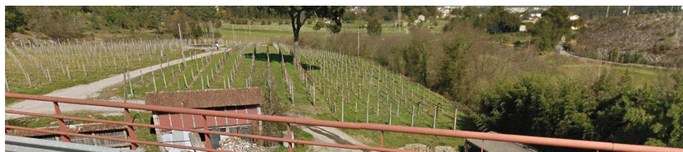
Vista a partir da A11 para o local de implantação da ETAR
