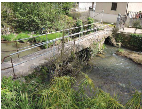
Quadro 4.61 – Ponte “Este 5” localizada na rua dos moinhos novos
