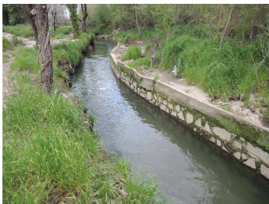
Figura 4.84 – Aspecto de um troço da linha de água emparedada.
