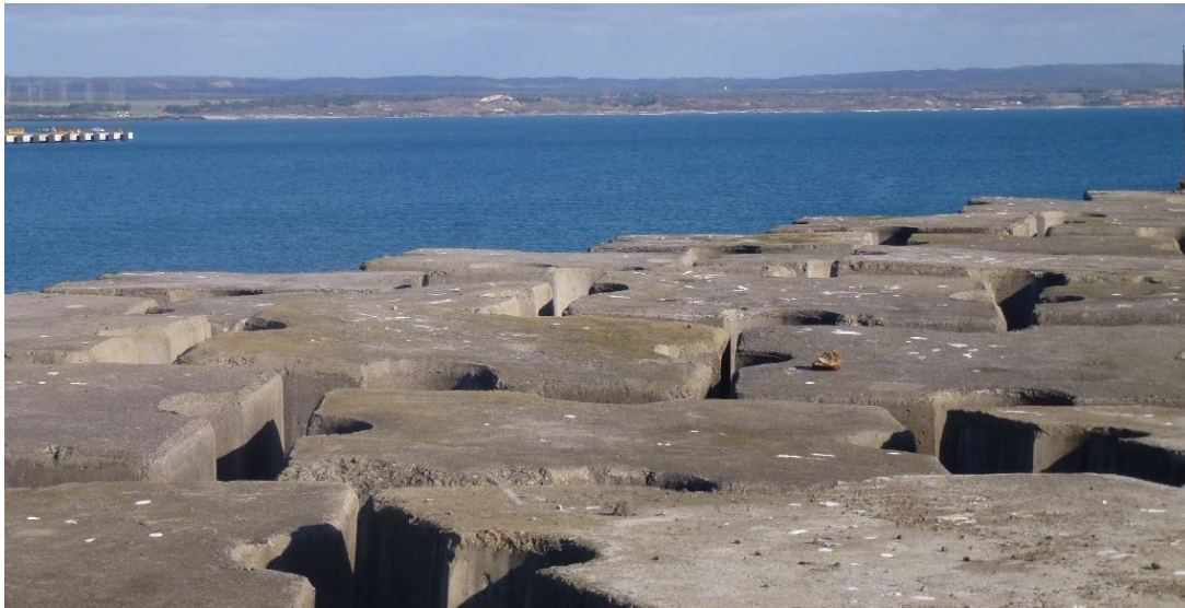
Figura 21 – Exemplo de disposição de blocos Antifer (quebra-mar do porto de Sines)
