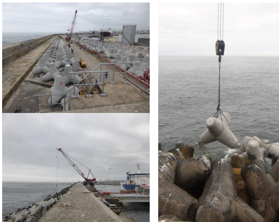
Figura 30 – Atividades de manutenção do manto de proteção do quebra-mar exterior (recarga de tetrápodes, julho de 2017)
