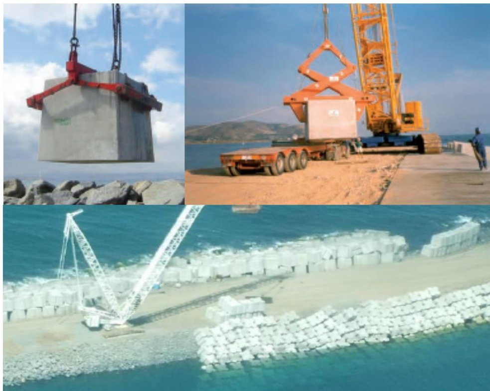
Figura 28 – Exemplos de colocação de blocos de betão
