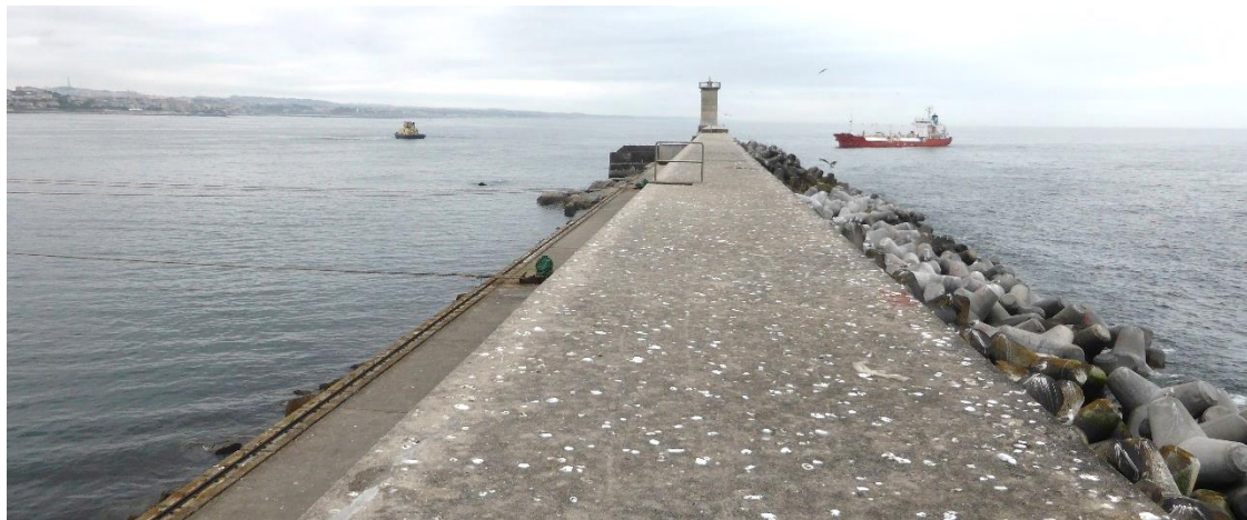
Figura 12 – Quebra-mar exterior, na situação atual [vista NNO-SSE a partir do topo do muro-cortina, à cota +15 m (ZHL)]
