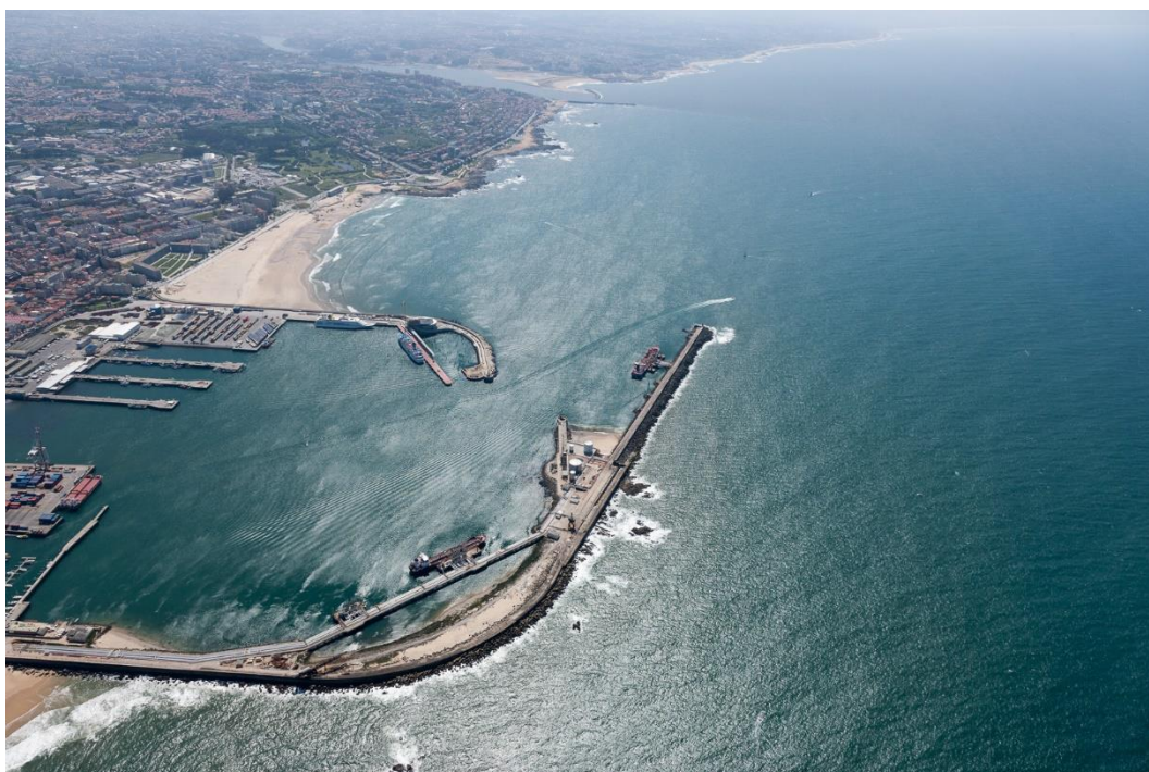
Fonte: João Ferrand - Fotografia; Lda (2014) À esquerda o quebra-mar sul e à direita o quebra-mar exterior (norte). A meio (a sul) a praia de Matosinhos e ao fundo a foz do rio Douro.
