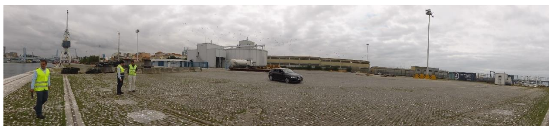
Figura 25 – Zona prevista para stockagem de enrocamentos (terminal cimenteiro, na zona sul do porto)
