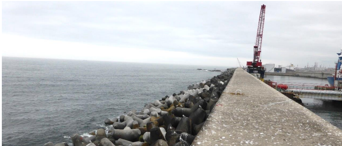
Figura 13 – Quebra-mar exterior, na situação atual [vista SSE-NNO a partir do topo do muro-cortina, à cota +15 m (ZHL)]
