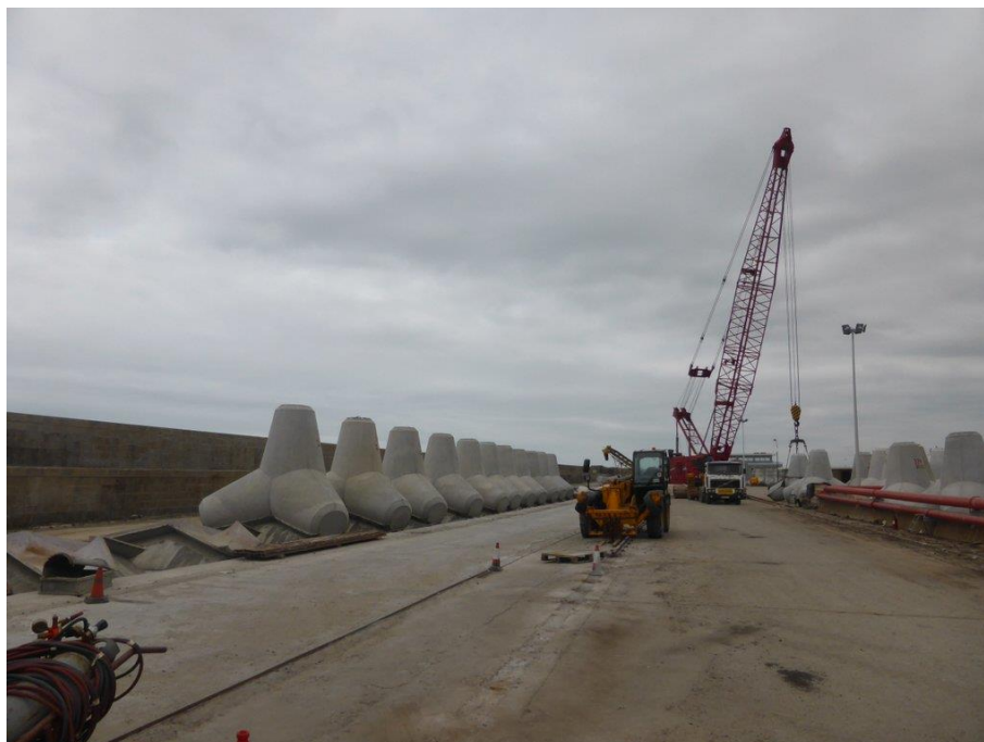
Figura 24 – Zona possível para stock de blocos artificiais, junto ao estaleiro (obra de recarga de tetrapodes no quebra-mar exterior, julho 2017)
