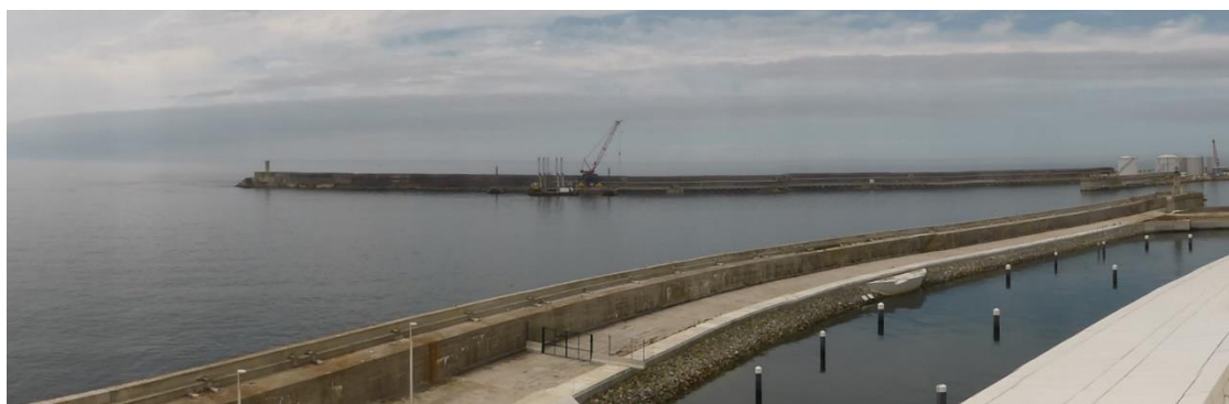
Quebra-mar exterior (norte) ao fundo, e quebra-mar sul, em primeiro plano.
