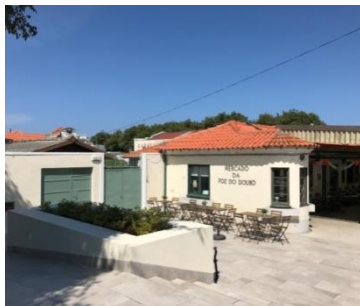
Figura 207 – Visibilidade para a área de intervenção do mercado da Foz
