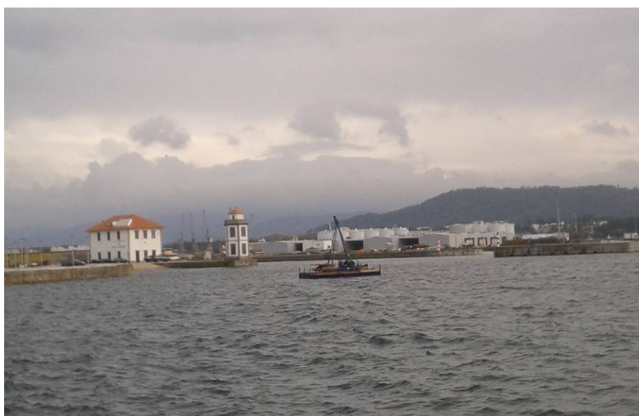
Foto 1 – Plataforma flutuante com equipamento de furação
