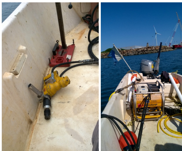
Fig. 13 – Equipamento de carotagem de rocha..
