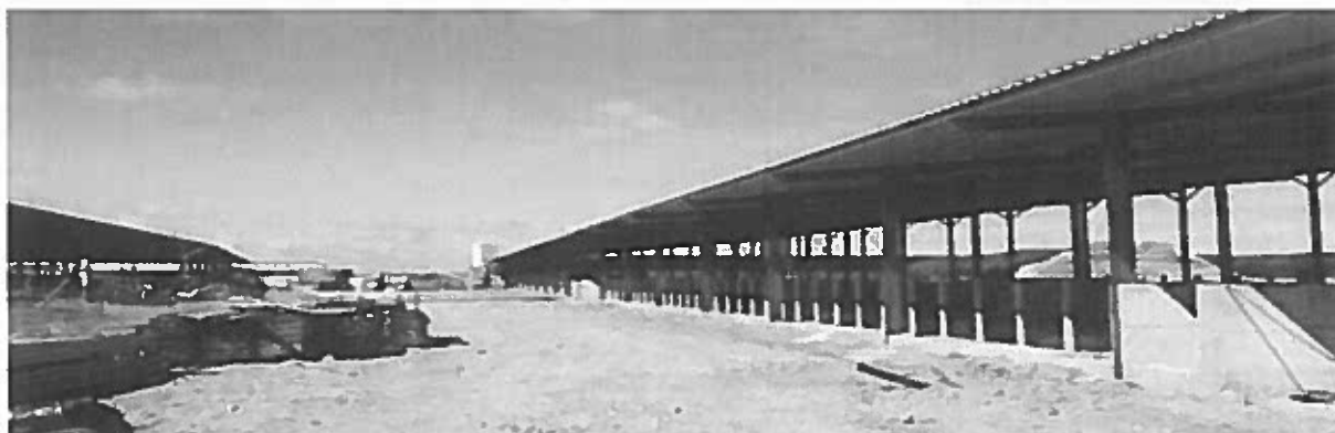
Figura 5 - foto de zona dos pavilhões
