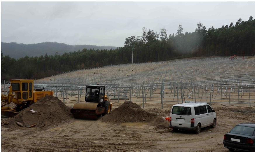
Figura 6 – Aspeto geral após regularização do terreno e instalação das estruturas metálicas de suporte dos módulos fotovoltaicos (Fonte: Grupo DST).
