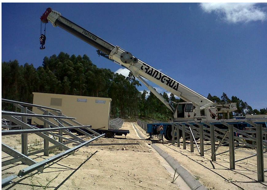
Figura 7 – Instalação do inversor/transformador (Fonte: Grupo DST).
