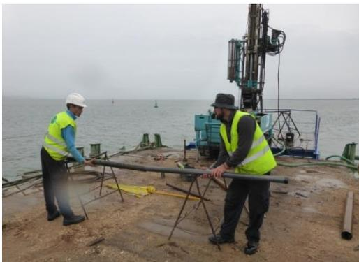
Figura 225 – Retirada de testemunho de sondagem
