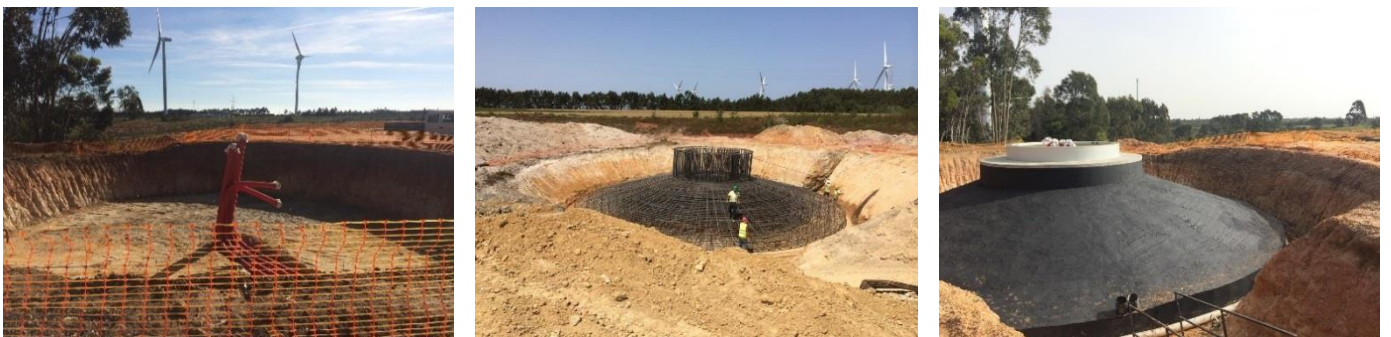
Figura 8: Execução da fundação das torres dos aerogeradores (abertura do cabouco para a fundação e betonagem do maciço de fundação).
