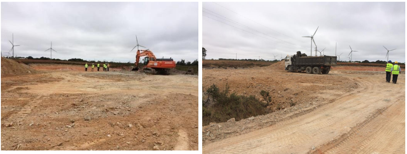
Figura 7: Trabalhos de decapagem e terraplanagens necessárias para a criação e beneficiação dos acessos e para a construção das plataformas
