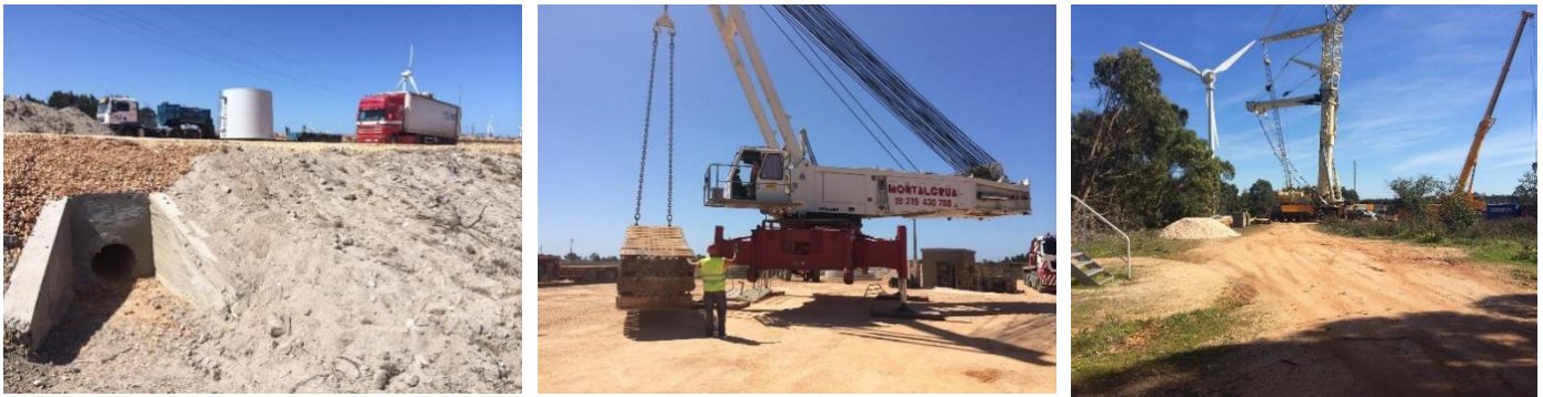
Figura 9: Operações de montagem e desmontagem do equipamento principal (aerogeradores) e equipamentos auxiliares.
