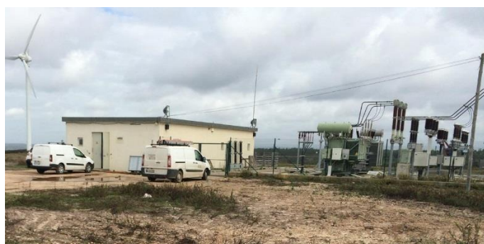
Figura 6: Equipamentos atualmente existentes e que continuarão a ser utilizados no âmbito do presente projeto, Linha elétrica aérea, de 60 kV e 15,3 km entre Picos Verdes e Lagos, e edifício de comando e subestação existentes, da esquerda para a direita.
