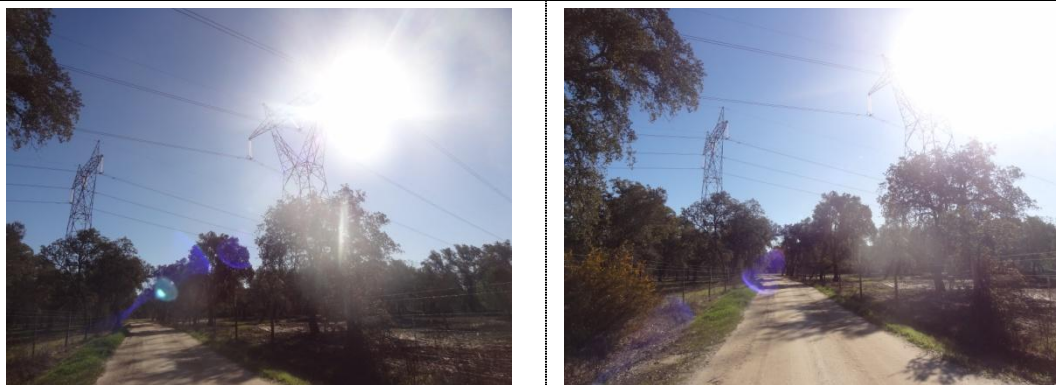
Figuras 3.14 e 3.15 – Linhas de Muito Alta Tensão da REN S.A.
