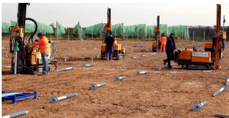
Fotografia 2. Equipamento utilizado para a perfuração hidráulica
