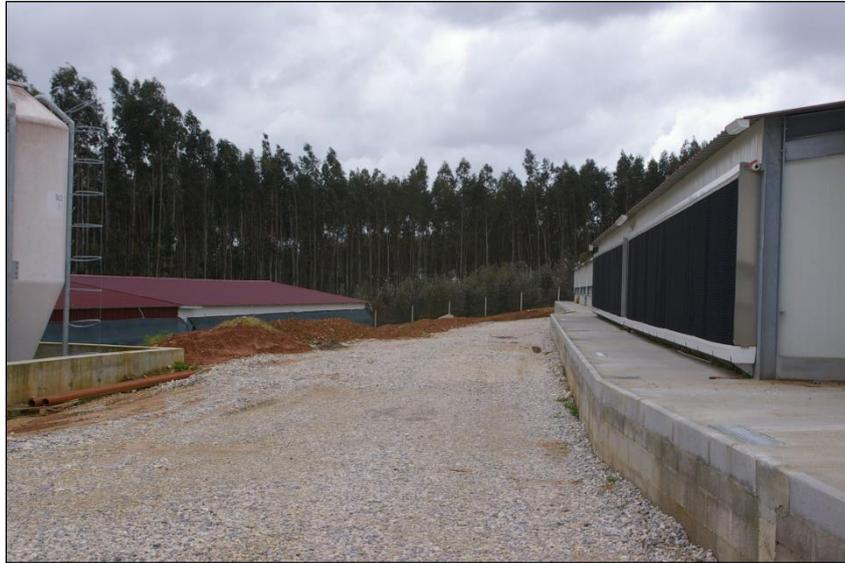
**Figura 16- Humidificação/arrefecimento**
