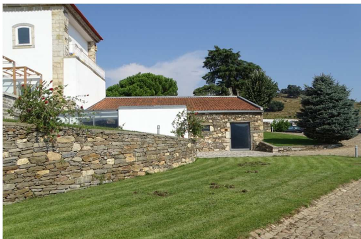
Vista do local impermeabilizado e edificado onde se procederá à demolição das instalações sanitárias e à ampliação da sala de eventos (Piso -2)
