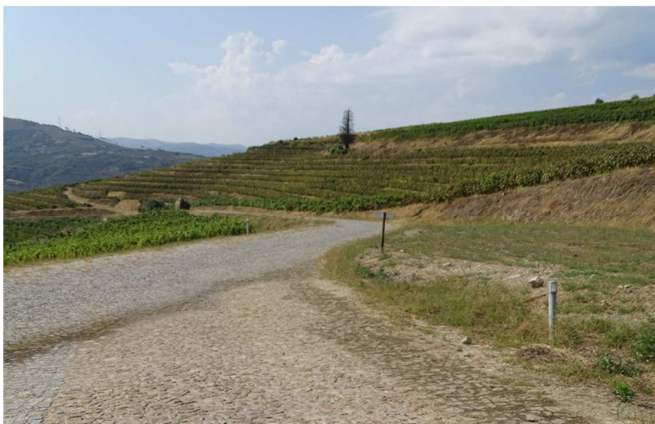
Vista do local onde se pretende instalar o estaleiro de obra e posteriormente o reservatório de gás
