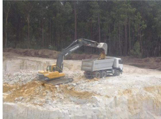
**Fotografia 4 - Carga de materiais na frente do desmonte.**
