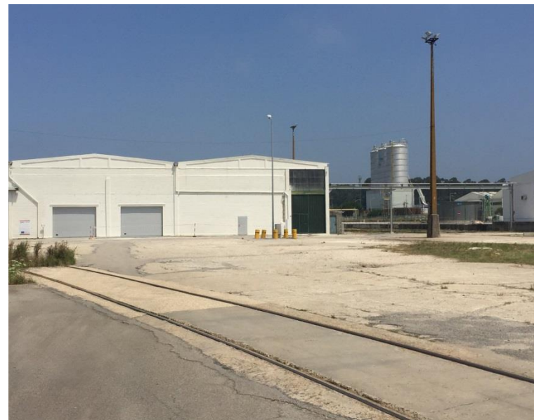
Figura 8- Edifício onde o projeto será instalado e envolvente próxima .
