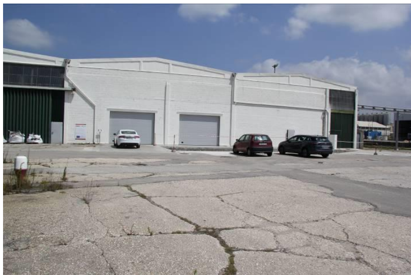
Figura 5 – Edifício onde o projeto será instalado.
