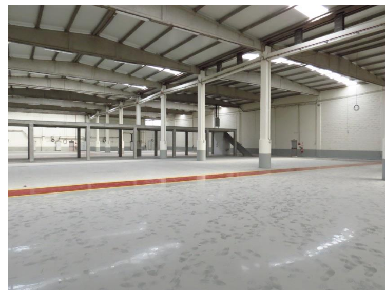
Figura 3 - Interior do edifício onde serão colocados os equipamentos.
