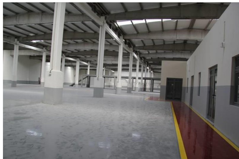
Figura 6 – Interior do edifício onde o projeto será instalado.
