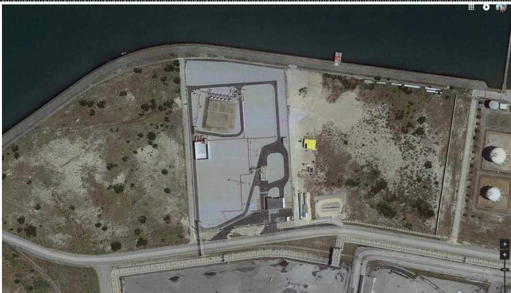
Figura 3.4 – Vista aérea – Parque de GPL (zona envolvente)
