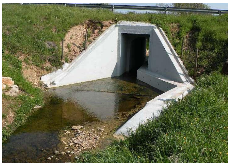
Figura 9 – Exemplo de uma Passagem Hidráulica adaptada para fauna através da implementação de um passadiço (imagem de: Garcia, G. (2015))
