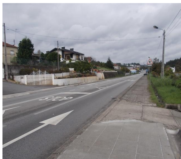
Figura 7 – Vistas da N14 ao km 2+508, na zona de término do traçado com implantação da interseção giratória.
