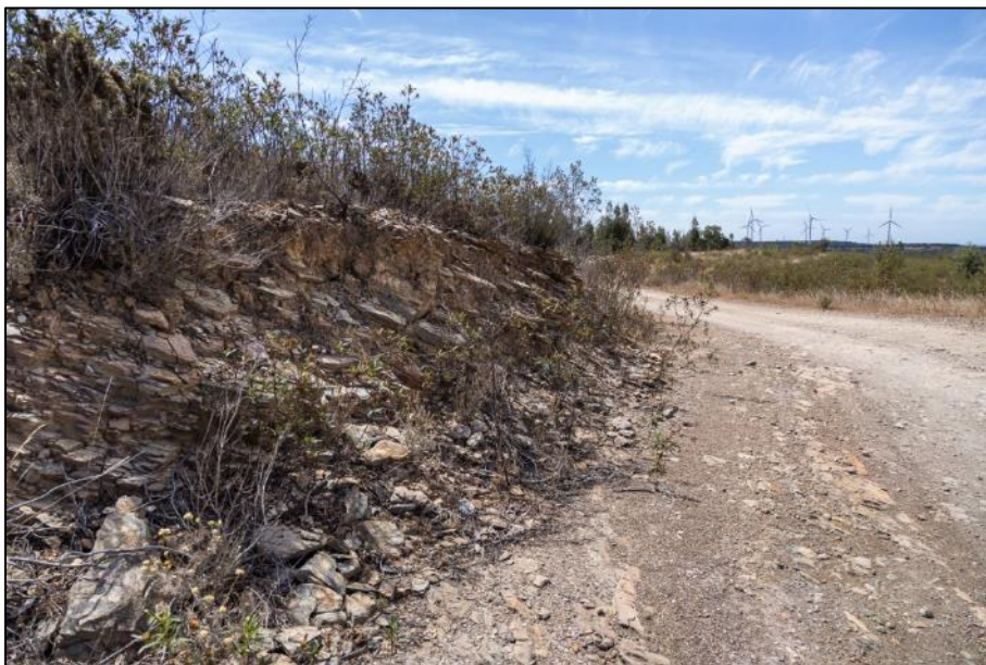
Figura 69 - Aspecto geral de um talude de escavação onde é possível observar a reduzida espessura de solo de alteração residual que cobre o substrato rochoso competente mas fracturado.
