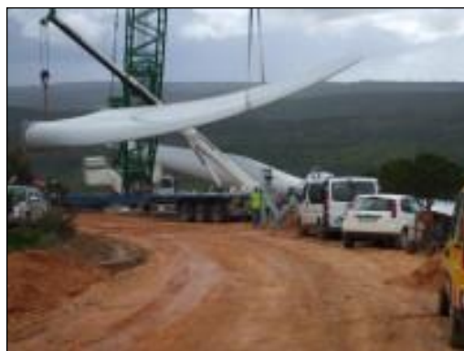
Figura 9 - Imagem exemplificativa de motagem de torre e pá de aerogerador. Fonte: STRIX
