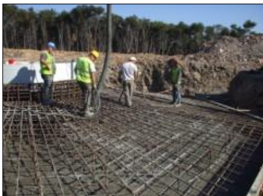
Figura 8 - Imagem exemplificativa de cofragem e betonagem da sapata de aerogerador. Fonte: STRIX
