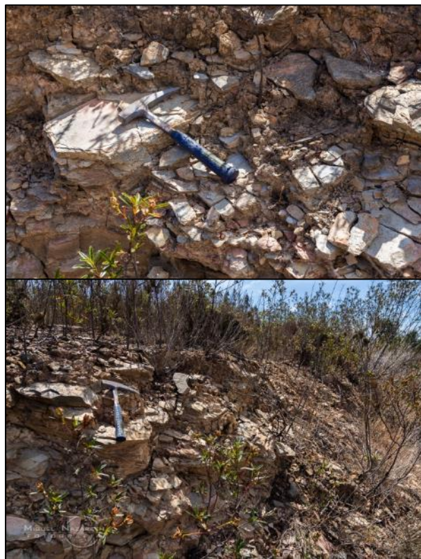
Figura 70 - Pormenores de afloramento existente num talude de escavação, sendo visível os níveis de estratificação dos pelitos e a fraturação e desagregação no horizonte mais superficial do substrato rochoso.
