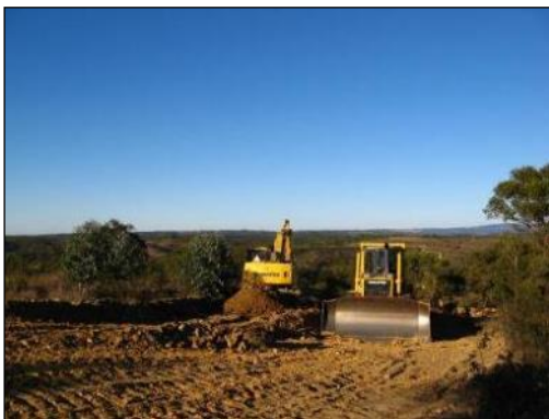
Figura 7 - Imagens exemplificativas de abertura de acessos e aplicação de tout-venant . Fonte: STRIX
