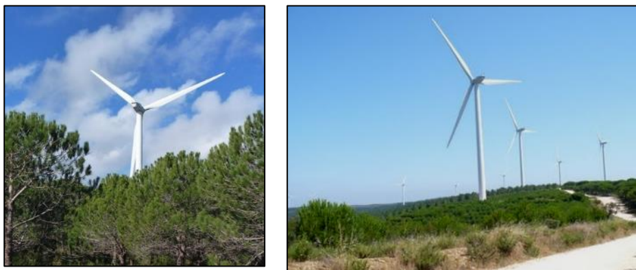
Figura 106 – Forte presença visual dos equipamentos do Parque eólico de Barão São João.
