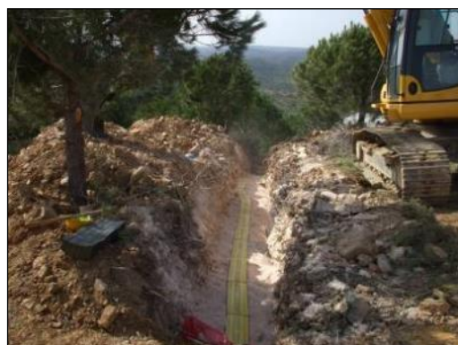
Figura 10 - Imagem exemplificativa de realização de vala de cabos. Fonte: STRIX
