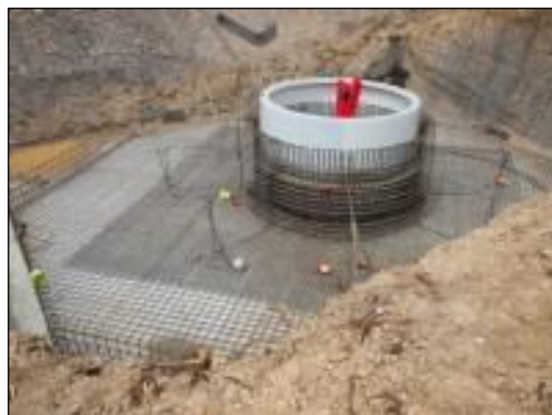
Figura 8 - Imagem exemplificativa de cofragem e betonagem da sapata de aerogerador. Fonte: STRIX
