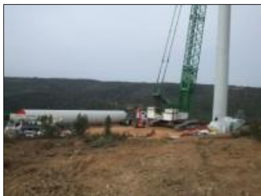
Figura 9 - Imagem exemplificativa de motagem de torre e pá de aerogerador. Fonte: STRIX
