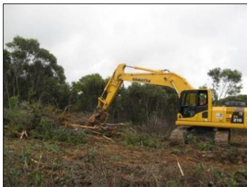
Figura 6 - Imagem exemplificativa de desmatamento para obras de construção de sapata de aerogerador. Fonte: STRIX
