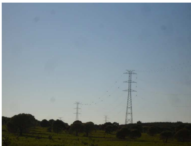
Foto 8 – Linha elétrica existente (ao longo do limite Norte do Corredor B1)
