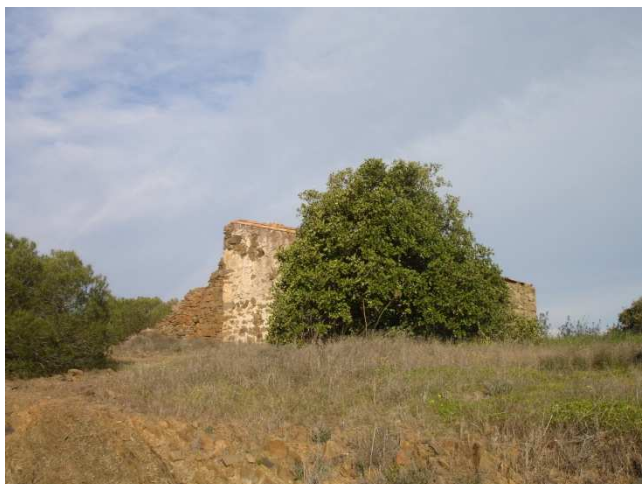
Foto 3 – Edifício agrícolas em ruína perto de Malfrade (Corredor B1/B2)
