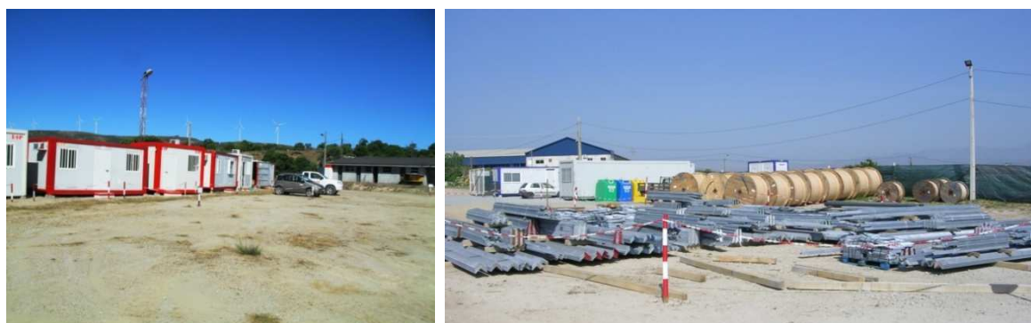
Foto 1 – Estaleiros de obras de construção de linhas
