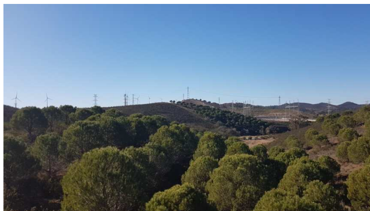
Foto 4 – Subestação de Tavira
