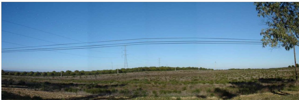
Foto 49 – Local de Implantação da Subestação da Central Fotovoltaica de São Marcos e Corredor A (paralelo á linha de 400 kV já existente)
