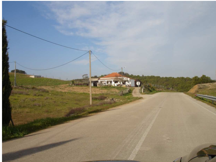
Foto 55 – Habitação localizada no limite este do Corredor B1 (km 13+500) e dentro do Corredor B2 (km 12+500) na envolvente de Malfrades
