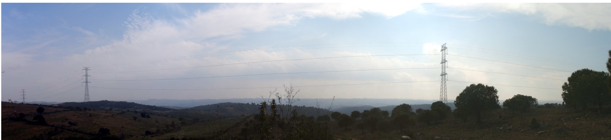
Foto 50 – Visibilidade para o Corredor B1 perto da povoação de Marim (entre o km 7+000 e 8+000): A linha elétrica existente corresponde ao limite do corredor em estudo no presente projeto
