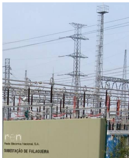
Fotografia 1 – Subestação da Falagueira
