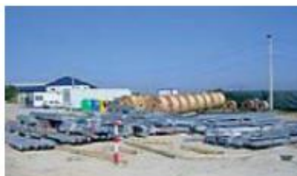
Fotografia 4 – Instalação de Estaleiro (fonte: Guia REN)
