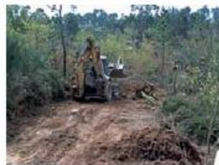
Fotografia 5 – Desmatamento (fonte: Guia REN)
