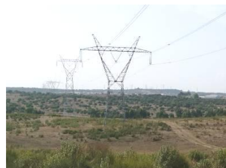
Fotografia 2 – Linha Falagueira – Cedillo, a 400 kV
