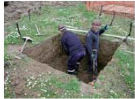
Fotografia 6 – Escavação de caboucos (fonte: Guia REN)
