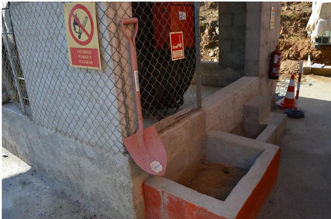
Figura 14 – Depósito de combustível com bacia de retenção e kit de emergência.
