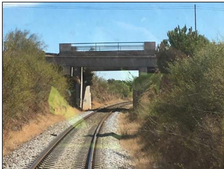
Figura 18 – PS ao km 387+014 (situação existente)
