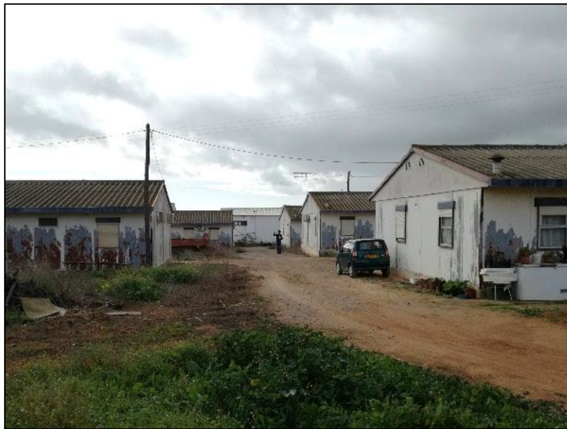
Figura 235 – Edifícios localizados na zona do restabelecimento da PN 371+317
