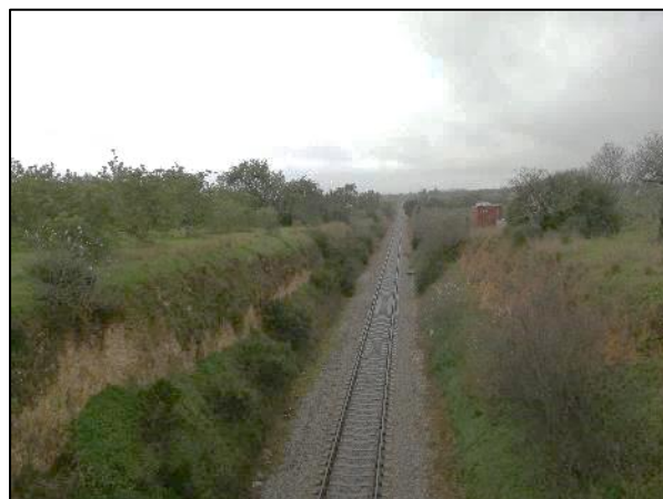
Figura 147 – Plataforma da ferrovia, a rebaixar
