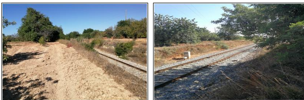
Figura 67 – Área relativa à intervenção do talude ao km 369+100
