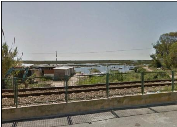
Figura 119 – Ancoradouro na laguna
