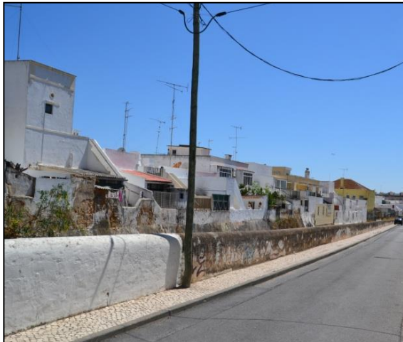
Figura 212 – Linha em escavação e entre muros em Olhão
