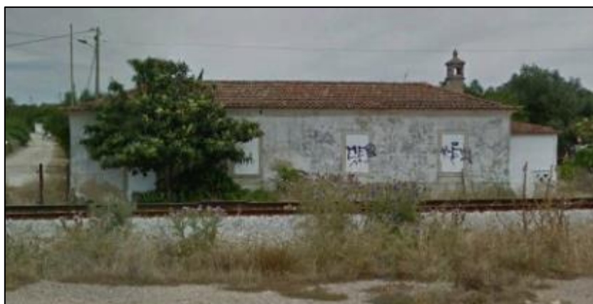
Figura 25 – Edifícios a reconverter no antigo apeadeiro de Marim
