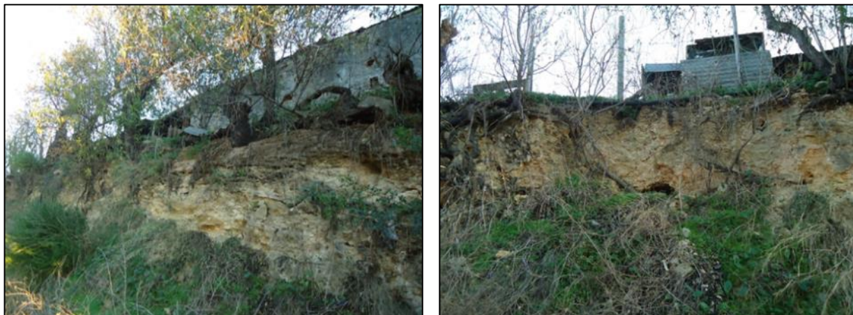
Figura 41 – Exemplo Depósitos do Plistocénico em talude de escavação ao km 365+000
