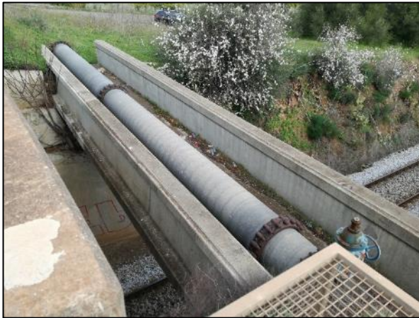
Figura 174 – Conduitas de abastecimento para regadio
