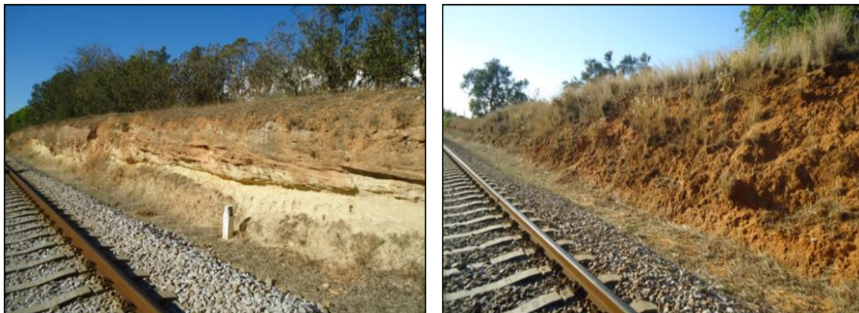
Figura 42 – Exemplo Depósitos do Miocénico em taludes de escavação aos kms 375+000 e 383+500
