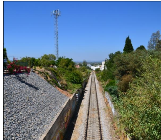
Figura 213 – Linha em escavação na Fuzeta
