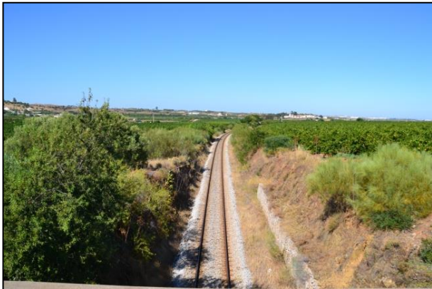
Figura 216 – Linha em escavação com pomares na envolvente na proximidade de Barrocal
