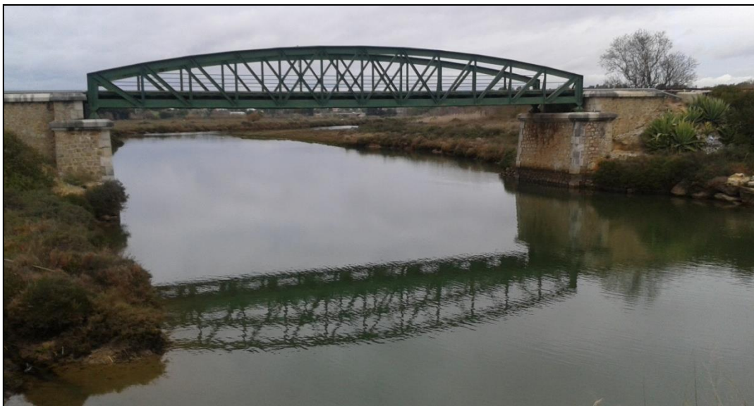
Figura 93 – Sapais a montante da linha e ponte ferroviária na ribeira de Almargem (km 375+500 / 376+000)
