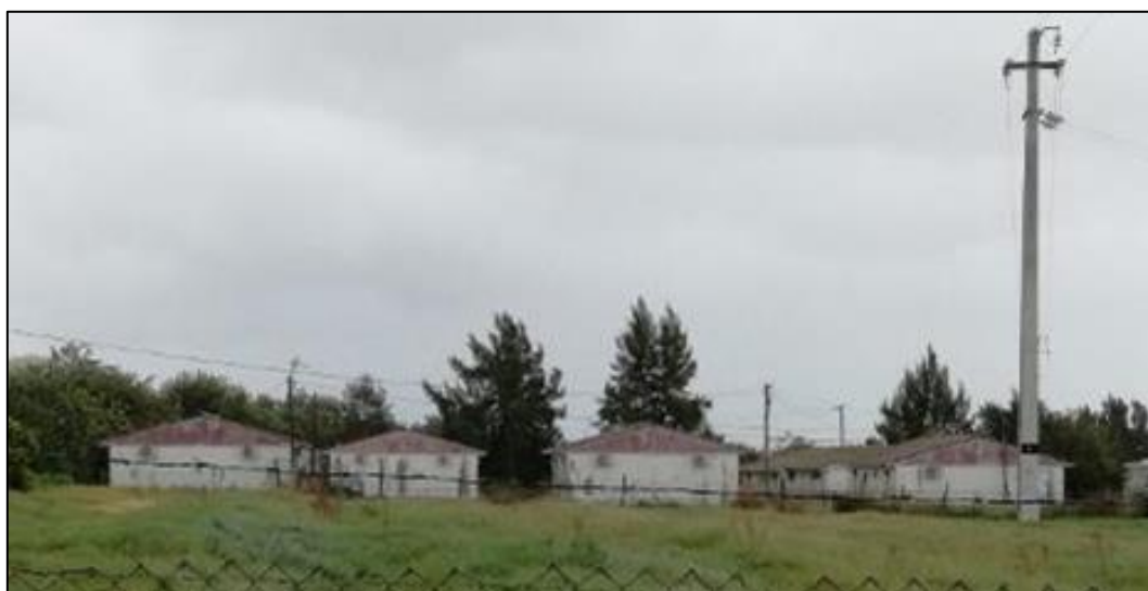
Figura 13 – Fotos dos edifícios (pré-fabricados) a demolir para o restabelecimento da PN 371+317
