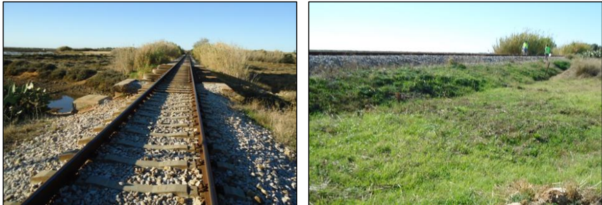
Figura 37 – Exemplo de estruturas de aterro com alturas máximas até 4 m assentes em baixas de carácter aluvionar. Baixa aluvionar Rio Marim ao km 352+900 e ao km 356+700
