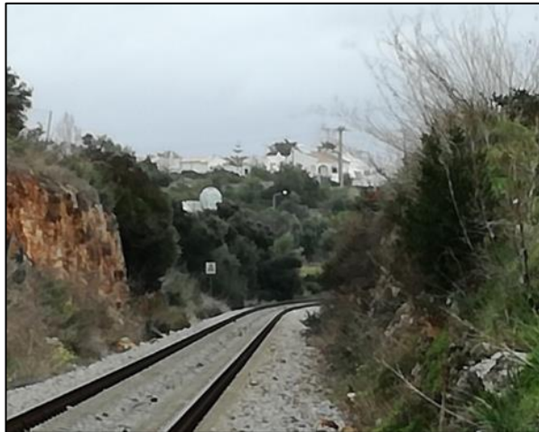
Figura 164 – Talude objeto de intervenção (à esq.)
