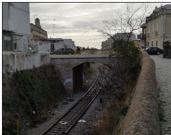
Figura 126 – Atual tabuleiro da PS (vista de poente)
