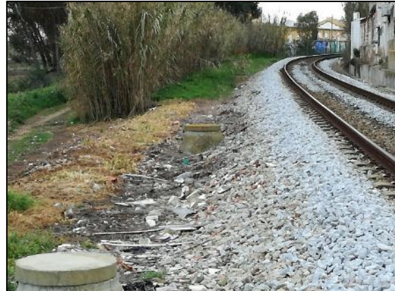
Figura 120 – Drenagem junto à linha
