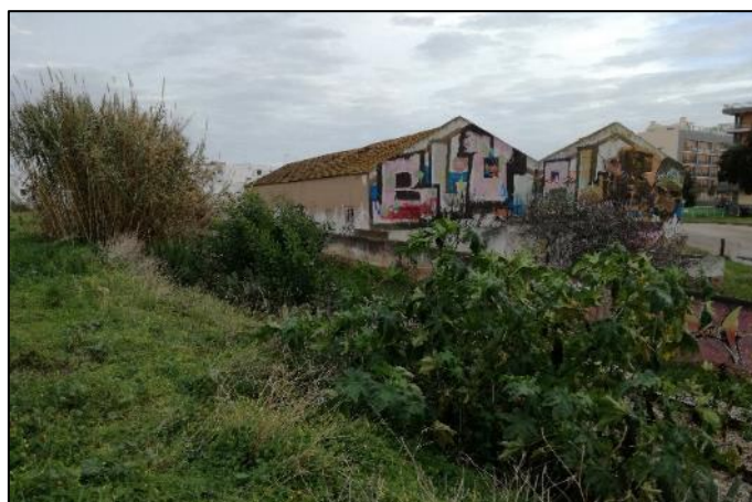
Figura 61 – Área relativa à intervenção do talude ao km 348+950
