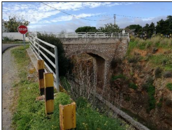
Figura 170 – Talude a intervir (à direita)
