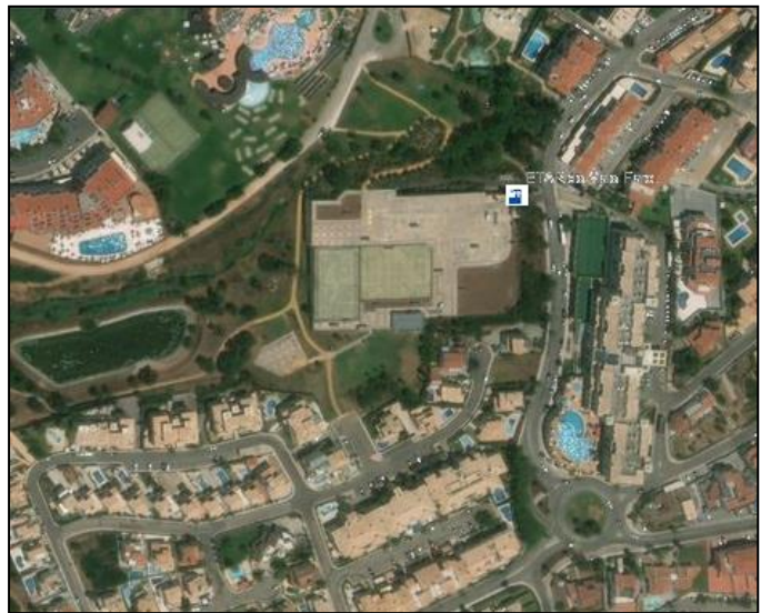
Figura 80 – ETAR de Vale Faro
