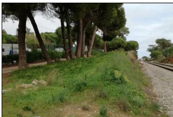
Figura 135 – Talude objeto de intervenção
