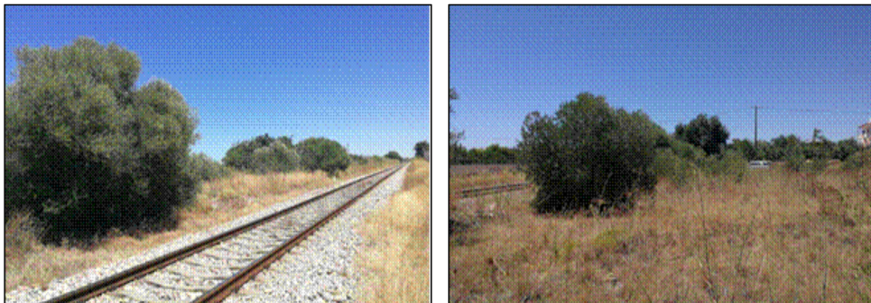
Figura 63 – Área relativa à intervenção do talude ao km 363+450
