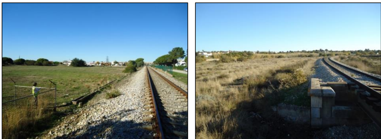
Figura 38 – Exemplo de baixas de carácter aluvionar. Foto da esquerda próximo do km 351+800 e foto da direita 353+000
