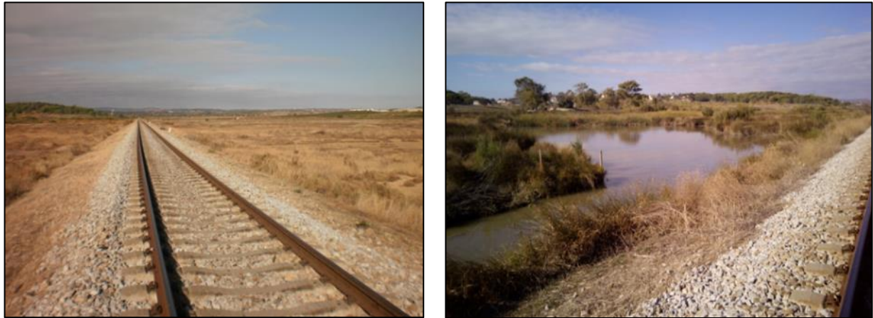
Figura 39 – Exemplo da zona aplanada com areias de duna onde se observam zonas alagáveis, a partir do Km 394+000
