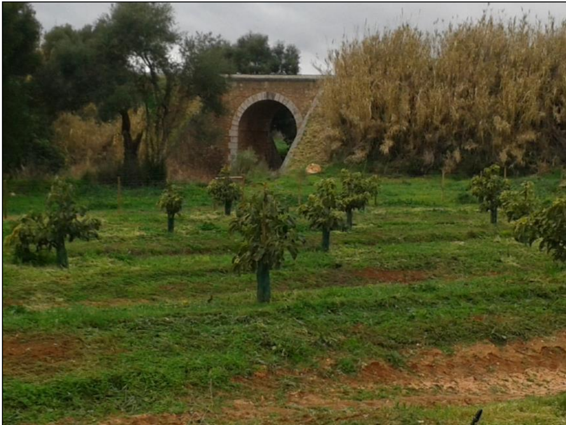
Figura 95 – Ponte ferroviária no atravessamento da ribeira do Álamo (km 386+300)
