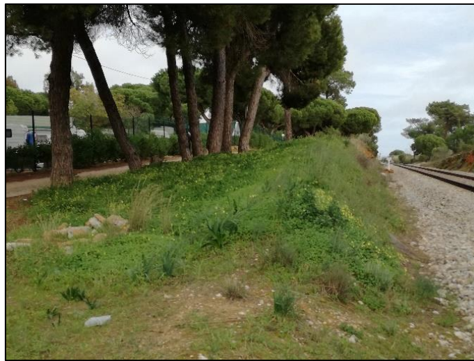
Figura 62 – Área relativa à intervenção do talude ao km 352+000
