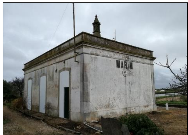
Figura 138 – Edifício do antigo apeadeiro
