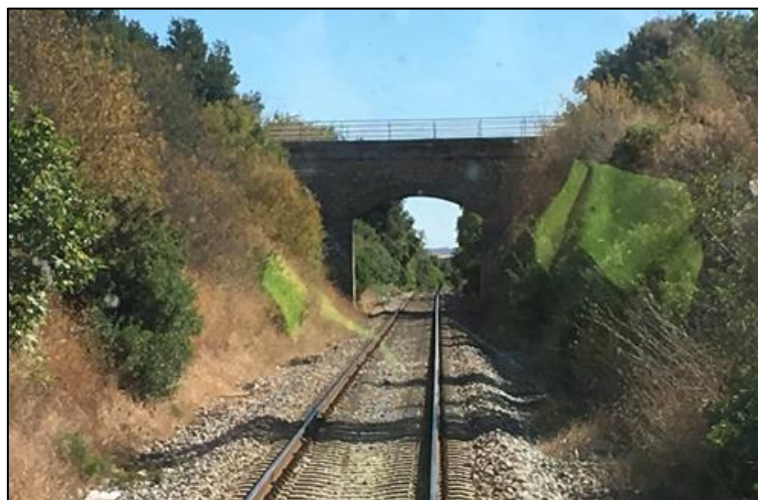
Figura 16 – PS ao km 367+736 (situação existente)
