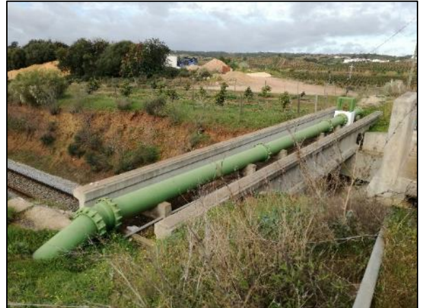
Figura 173 – Conduitas de abastecimento público
