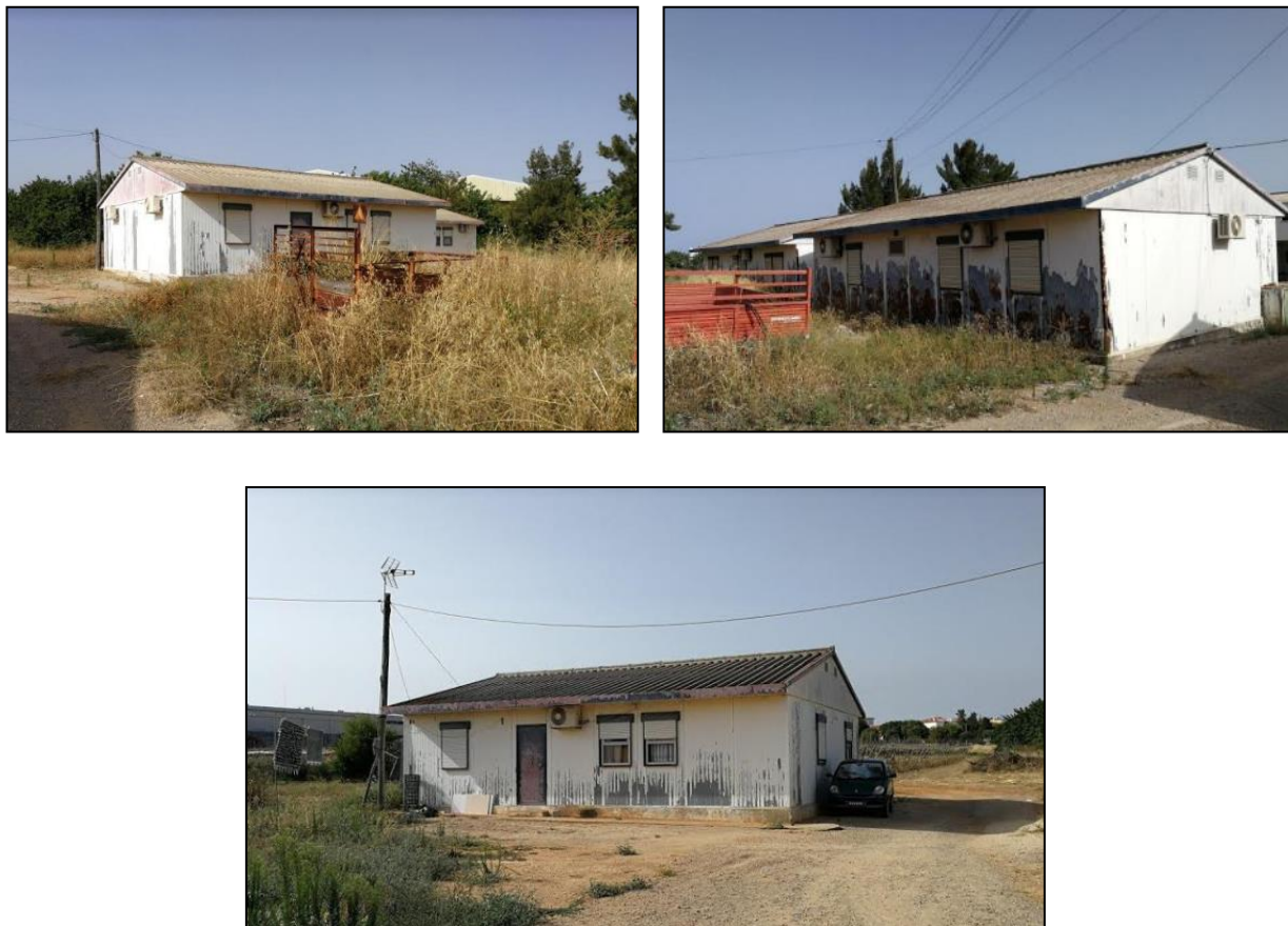
Figura 58 – Pré-fabricados a demolir existentes na zona da PN 371+317
