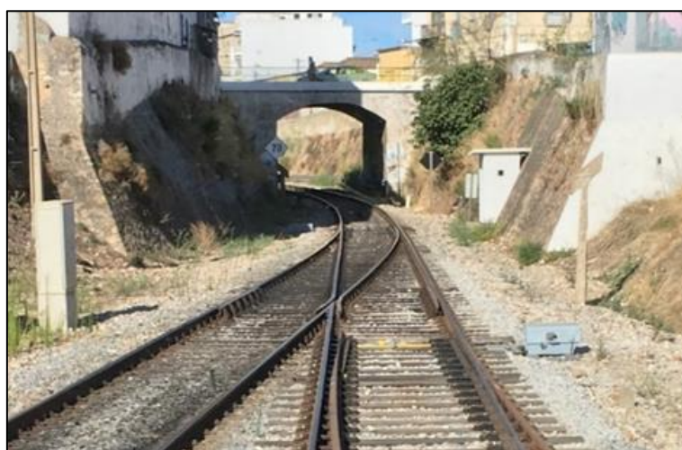
Figura 14 – PS ao km 349+681 (situação existente)
