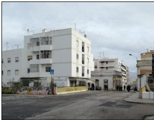
Figura 127 – PS na Rua 18 de junho
