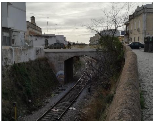
Figura 125 – Atual tabuleiro da PS (vista de nascente)
