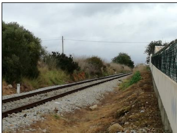
Figura 143 – Talude objeto de intervenção
