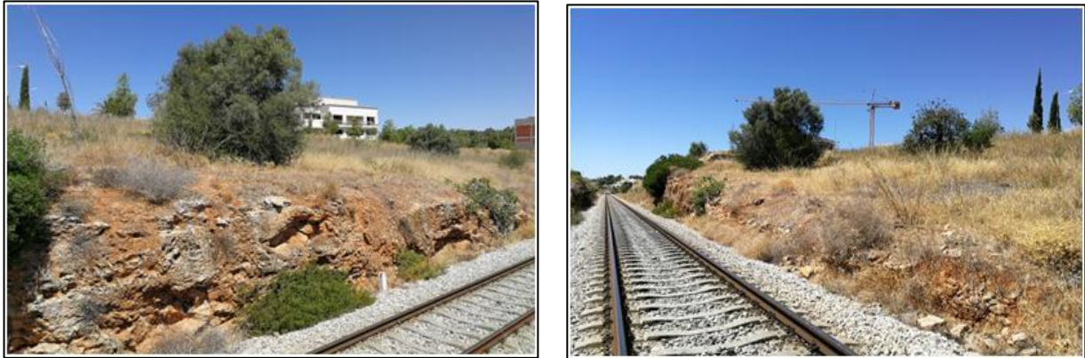
Figura 68 – Área relativa à intervenção do talude ao km 372+400
