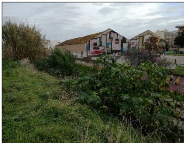
Figura 123 – Talude objeto de intervenção
