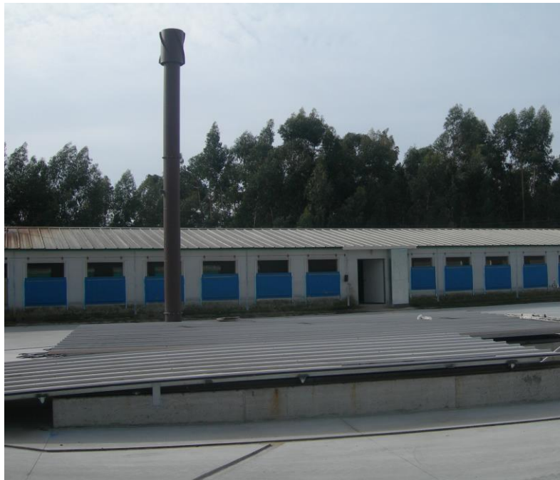
Figura 4- Instalação da Caldeira
