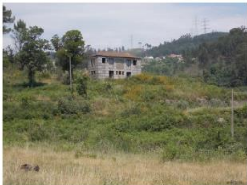
Figura 3.4 - Pavilhão antigo de arrumos ao km 0+400, lado esquerdo – sob o Ramo 2 do Restabelecimento 1 (EM 583)
