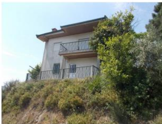
Figura 3.3 - Habitação localizada entre o Restabelecimento 1C e o traçado da Variante – situação de inviabilização total.
