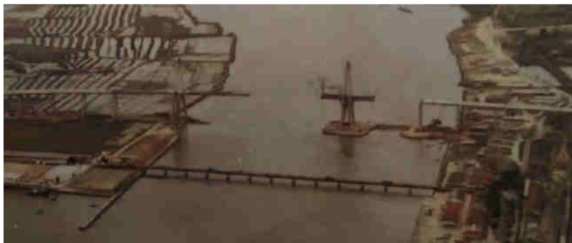
Figura 29 – Vista aérea da antiga ponte sobre o Rio Mondego durante a construção da nova ponte (Memória justificativa e descritiva do projeto, 2019, p, 57)
