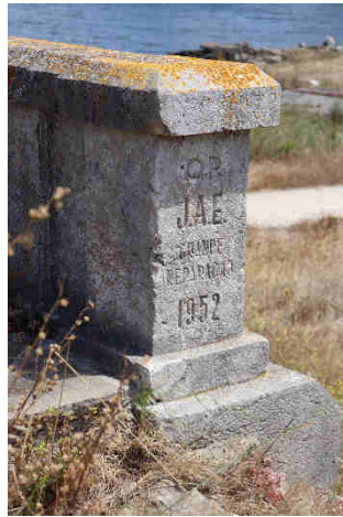
Figura 40 – Inscrição da JAE comemorativa das obras de melhoria executadas em 1952.
