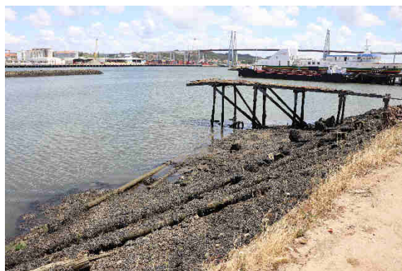
Figura 44 - Vista geral do cais de madeira e rampa
