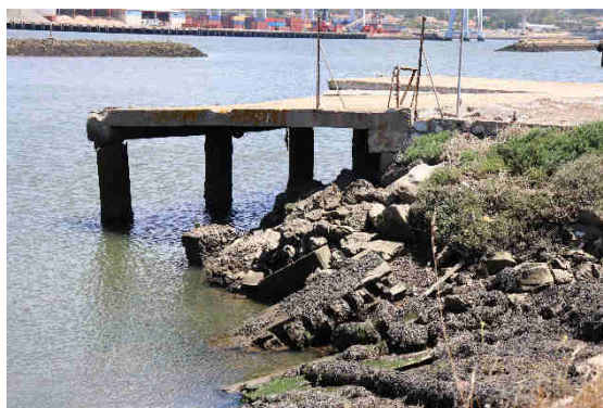
Figura 45 - Vista geral do cais de cimento
