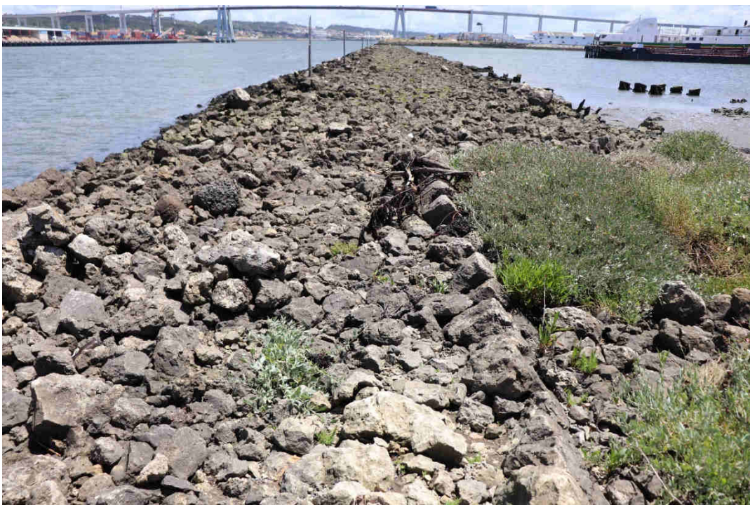
Figura 43 - Aspeto geral do molhe oeste
