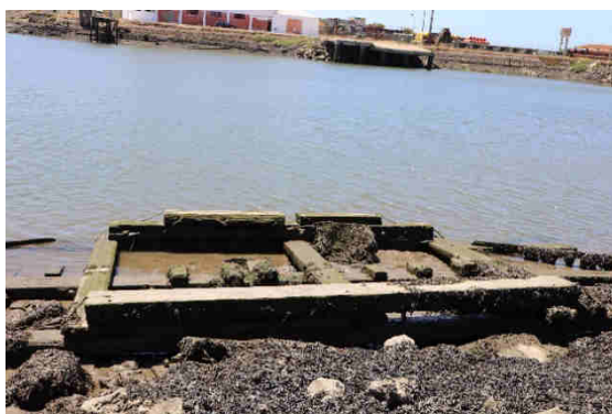
Figura 46 – Fragmentos de estruturas para subir e descer embarcações para a rampa/doca seca
