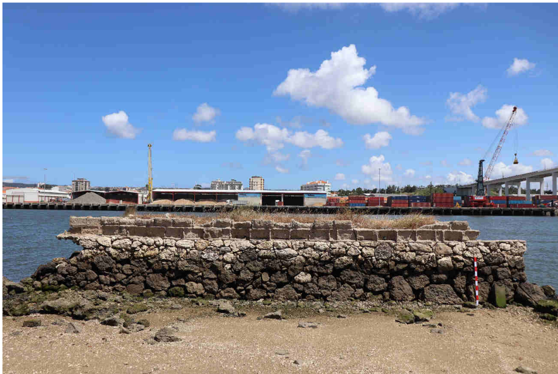
Figura 41 – Estrutura junto à margem alinhamento do pegão da ponte
