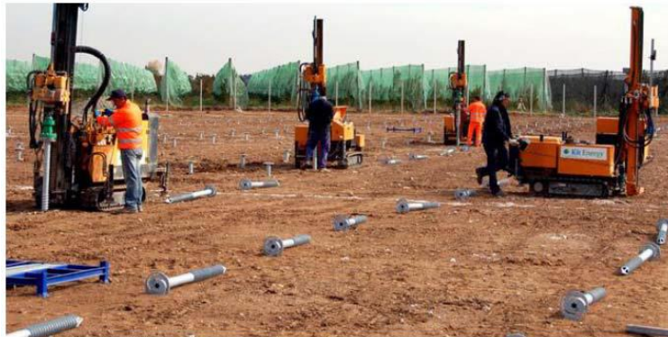
Fotografia 6. Equipamento utilizado para a perfuração (Fonte: EIA)
