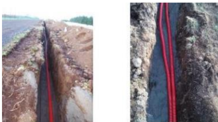
Fotografia 5. Exemplo de valas para cabos (Fonte: EIA)
