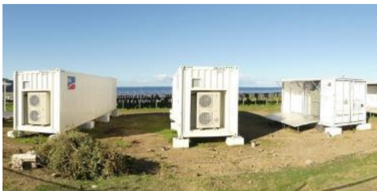
Fotografia 3. Solução assente em maciços de cimento (Fonte: EIA)
