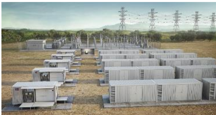
Fotografia 2. Parque de Baterias - solução centralizada (Fonte: EIA)
