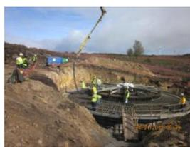
Execução da armadura da fundação do aerogerador
