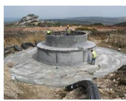
Betonagem da fundação do aerogerador
