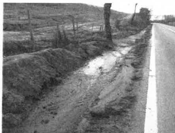
As fotos evidenciam areia na vala de drenagem da estrada nacional promovida pela erosão ocorrida devido à forma como foi mobilizado o solo
