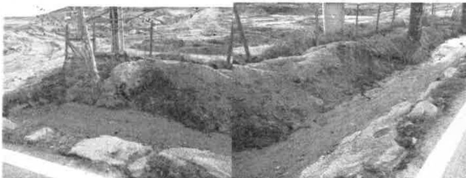
As fotos evidenciam areia na vala de drenagem da estrada nacional promovida pela erosão ocorrida devido à forma como foi mobilizado o solo
