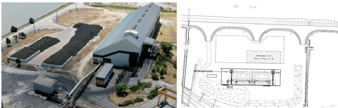
Figura 9 - Parque de Combustíveis Alternativos 1 onde será instalada a nova área de armazenagem coberta
