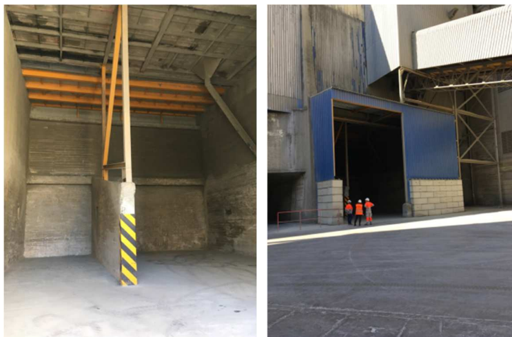
Figura 8 - Instalação Armazenagem – Armazém de Combustíveis Alternativos 2
