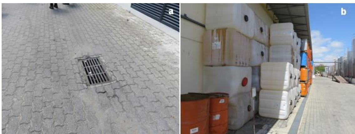
**Figura 5.38** - Sumidouros das águas pluviais no piso de circulação dos veículos (calçada com piso intertravado), considerado semipermeável (a) e da água dos telhados dos pavilhões (b).
