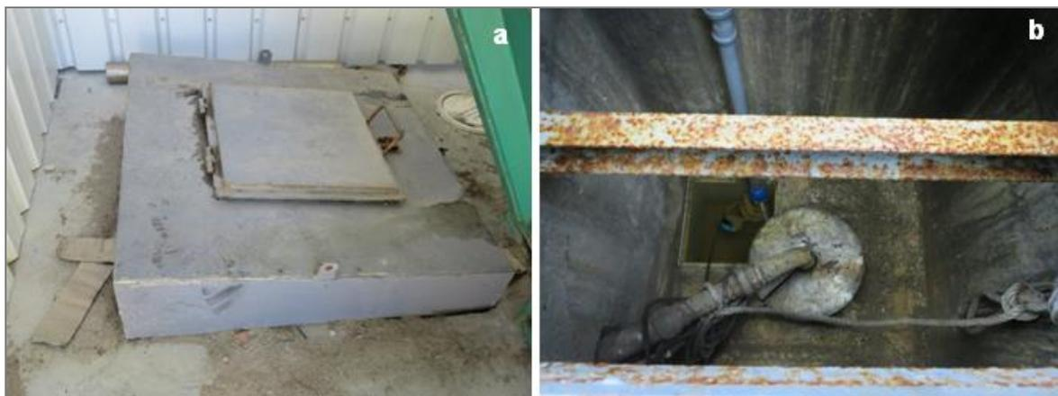
**Figura 5.22** - Caseta do furo: cobertura e tampa estanque (a) e interior da caseta com cabeça do furo (b).
