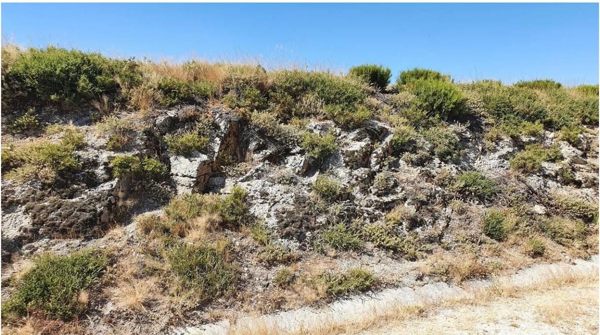
Figura 7 – Barreira de estrada a onde é possível observar o maciço granítico medianamente a muito alterado (talude NW)
