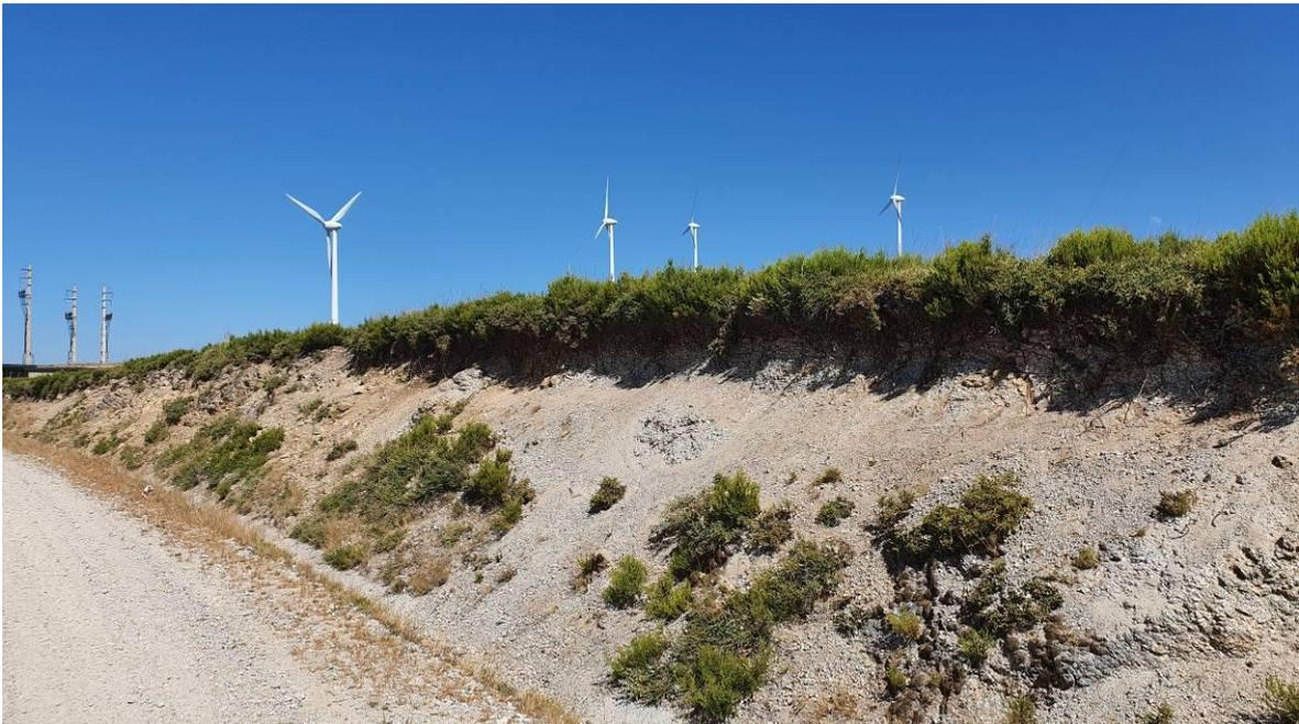
Figura 5 – Barreira de estrada onde é possível observar o maciço granítico medianamente a muito alterado (talude SE)
