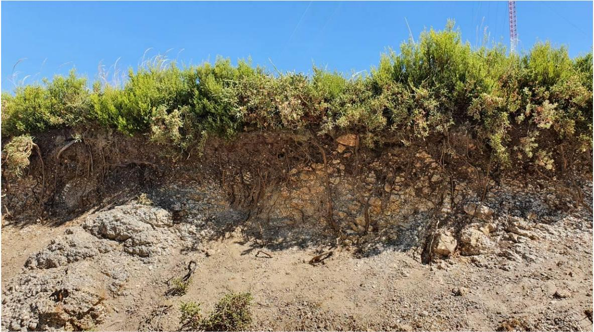
Figura 6 – Barreira de estrada onde é possível observar a espessura de terra vegetal e subjacentemente o maciço granítico muito alterado (talude SE)
