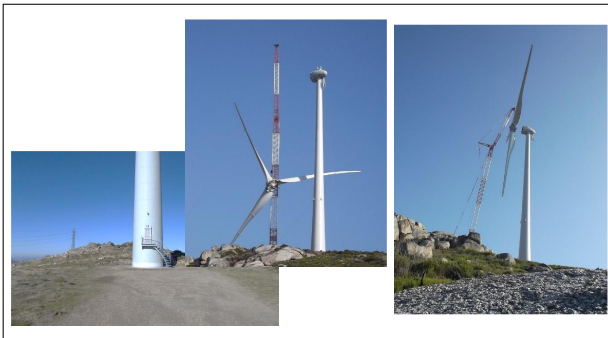
Fotografia 10 – Montagem da cabine e pás de um aerogerador.
