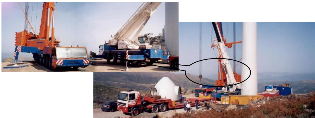
Fotografia 8 – Ocupação e dimensão de uma plataforma de trabalho para montagem de um aerogerador.
