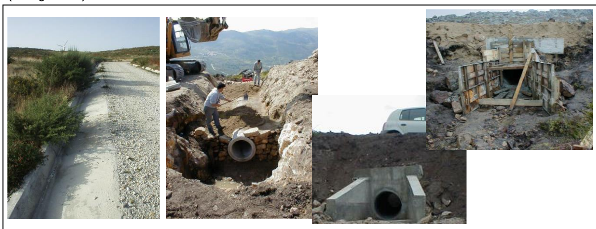
Fotografia 5 – Valeta e construção de uma passagem hidráulica.
