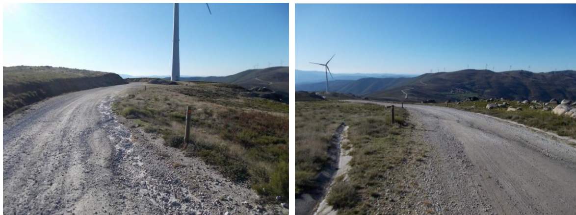
Fotografia 13 – Caminho de acesso existente.
