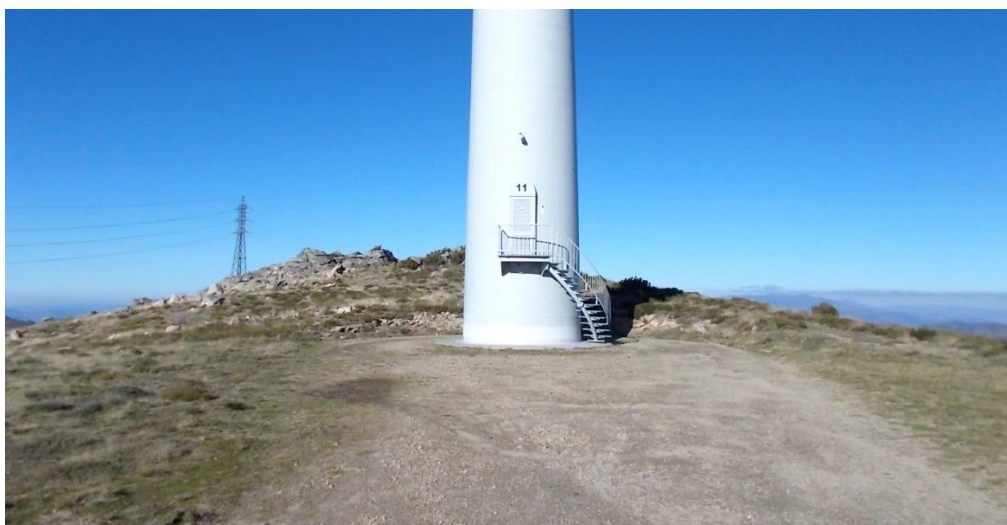
Fotografia 2 - Aspeto da plataforma de um aerogerador.
