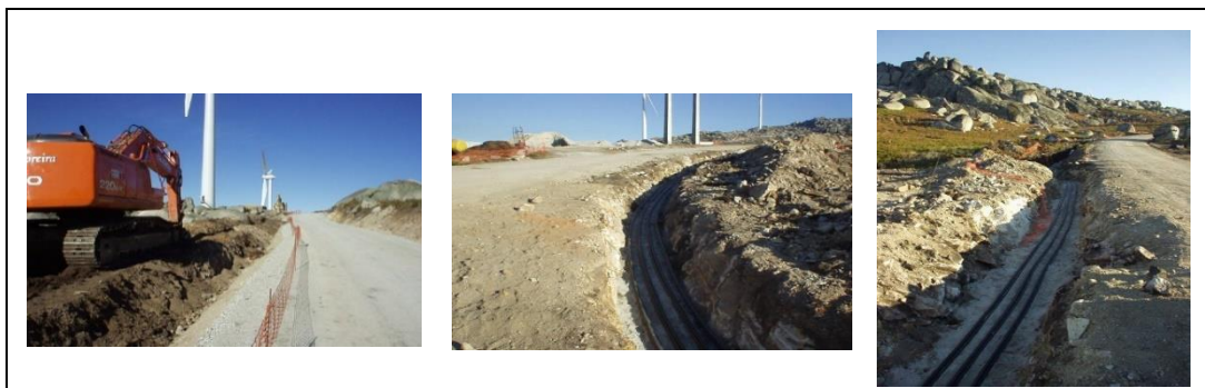
Fotografia 6 – Abertura de vala para instalação de cabos elétricos.
