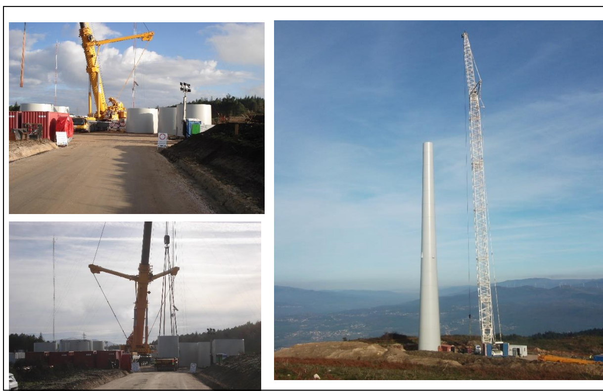
Fotografia 9 - Montagem de uma torre de aço.
