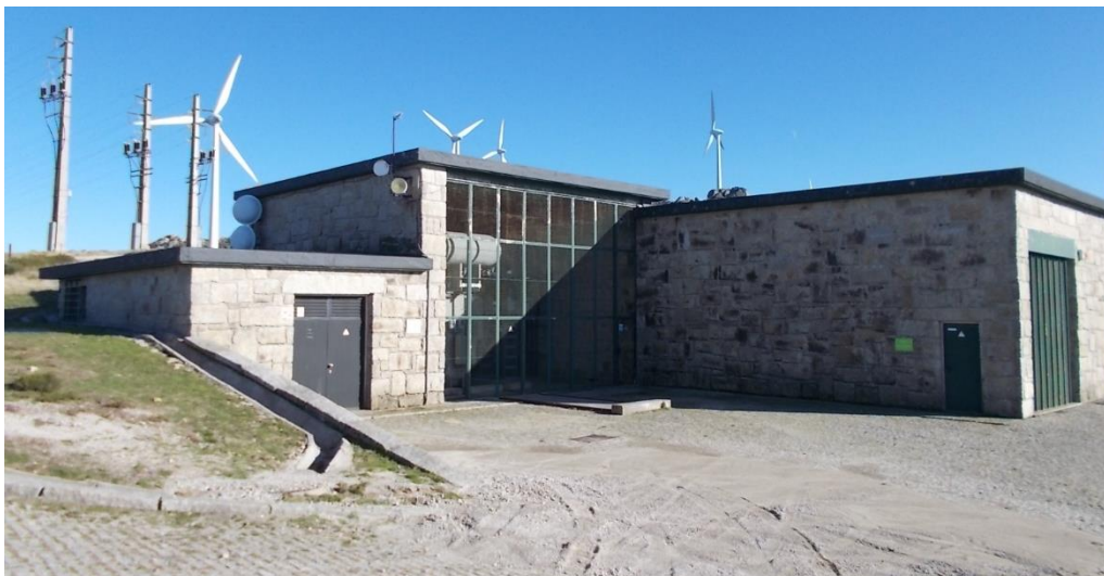
Fotografia 3 – Subestação existente e em exploração no Parque Eólico de Cabril, ao qual os aerogeradores do Sobreequipamento irão ligar-se através de cabos subterrâneos.
