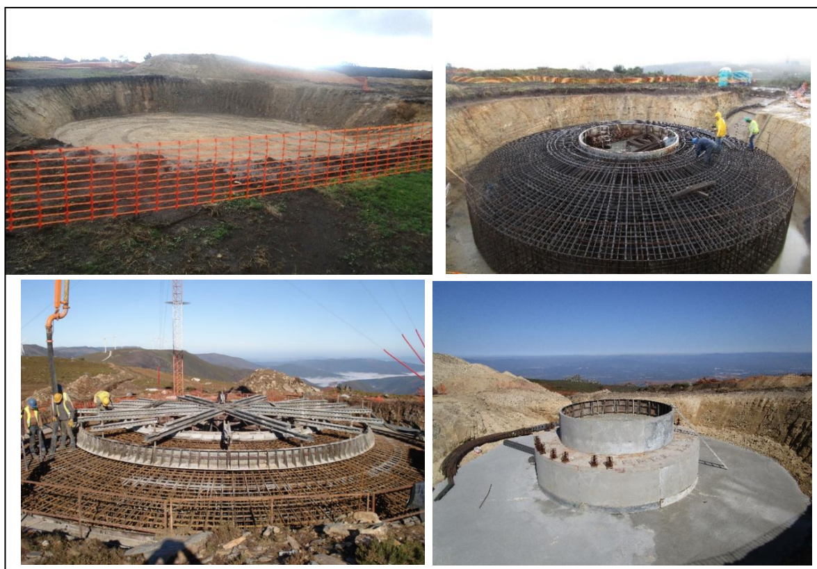
Fotografia 7 – Execução da fundação da torre de um aerogerador.
