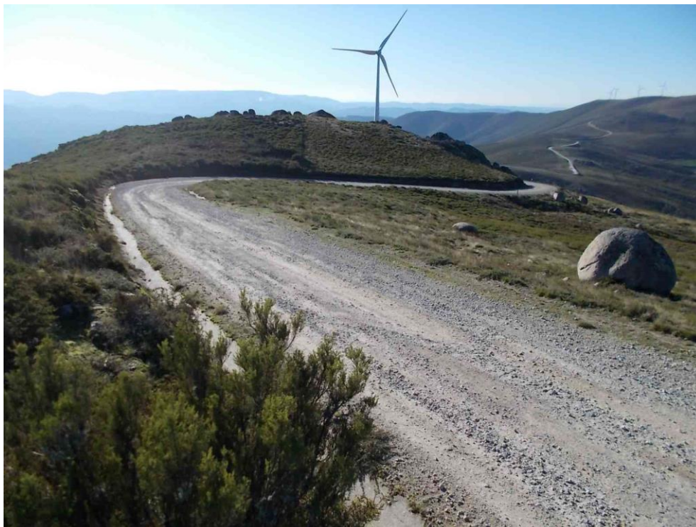
Fotografia 4 – Caminho de tout-venant existente no Parque Eólico de Cabril.
