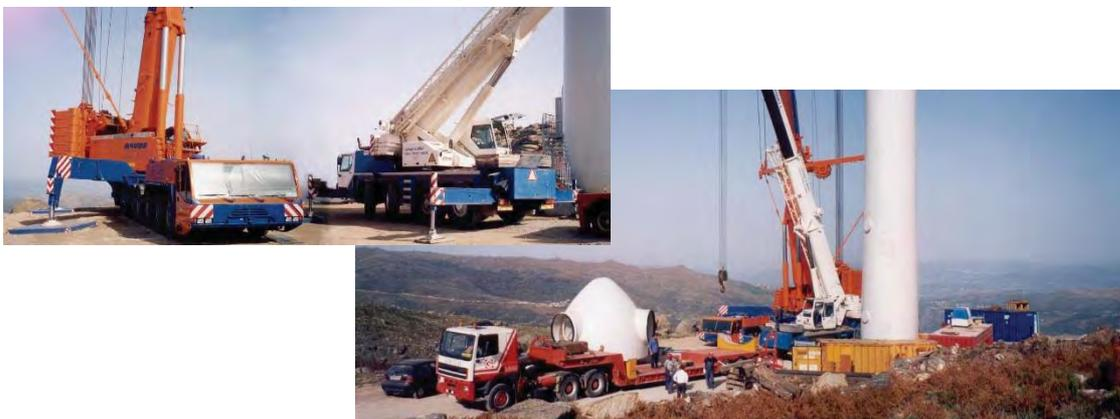
Fotografia 9 – Ocupação e dimensão de uma plataforma de trabalho para montagem de um aerogerador.
