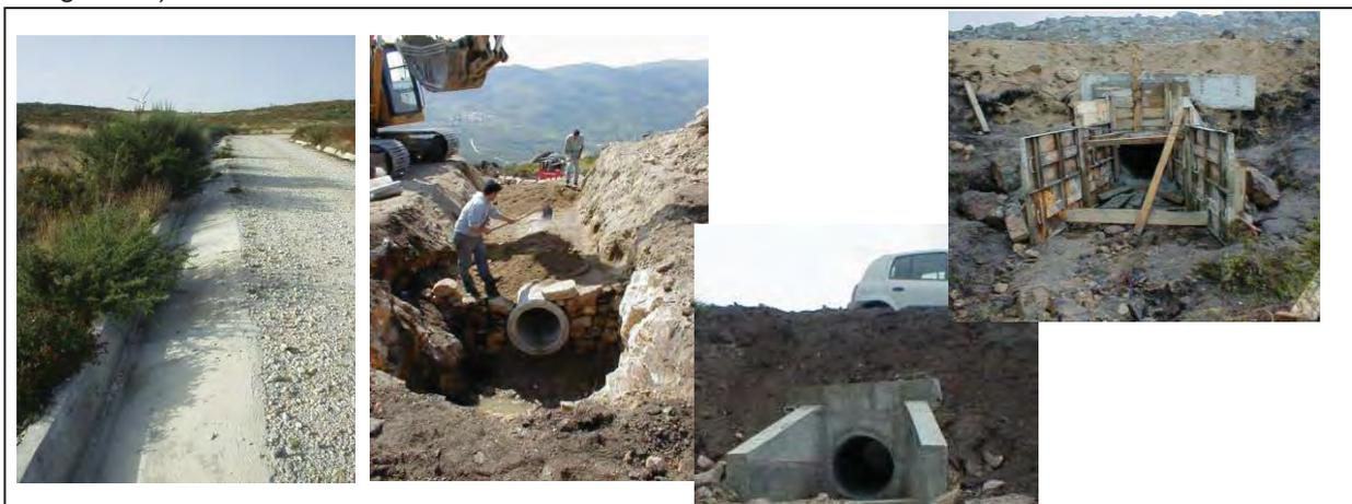
**Fotografia 6 – Valeta e construção de uma passagem hidráulica.**
