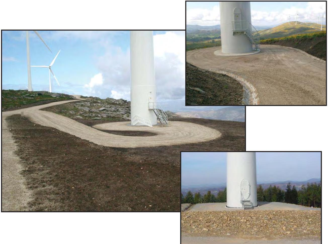
**Figura 3 – Exemplo da recuperação de plataformas de aerogeradores.**
