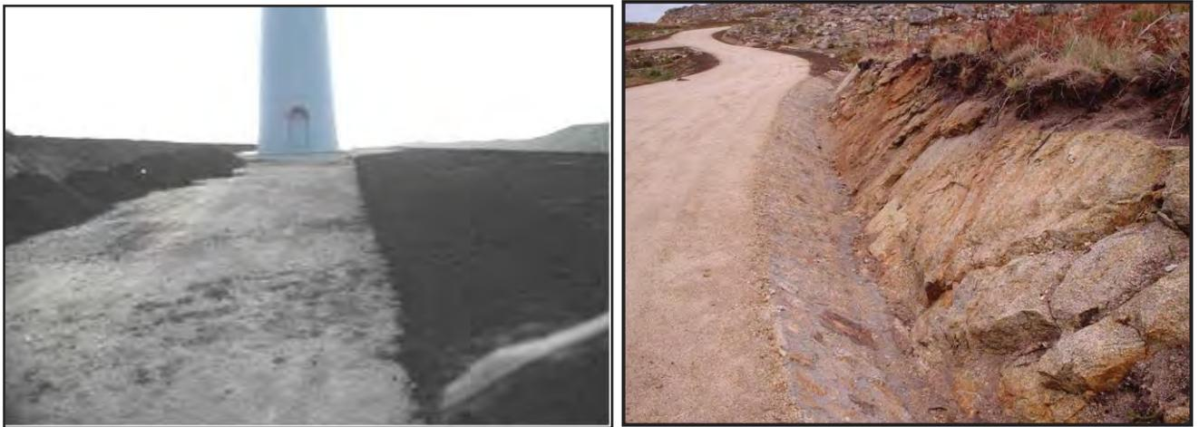
**Figura 1 – Exemplo da recuperação dos taludes de aterro que existem ao longo de caminhos de acesso a parques eólicos, com valetas em pedra.**
