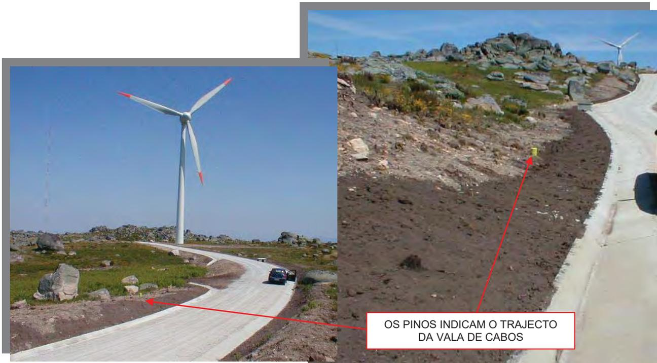
**Figura 4 – Exemplo da recuperação da zona adjacente ao caminho após o enterramento dos cabos eléctricos.**
