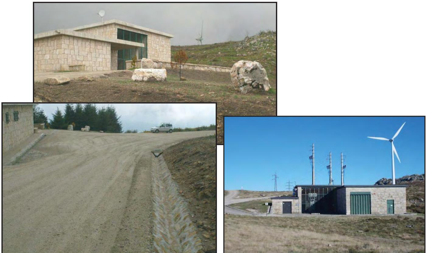
**Figura 5 – Exemplo da recuperação de bermas de caminhos e envolvimento de edifícios de comando/subestação.**
