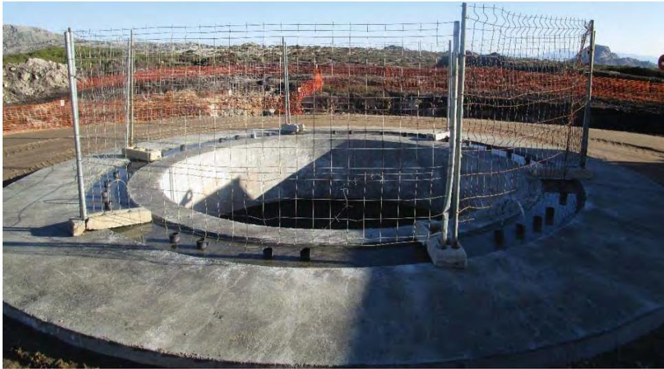
Fotografia 8 – Execução da fundação da torre de um aerogerador.
