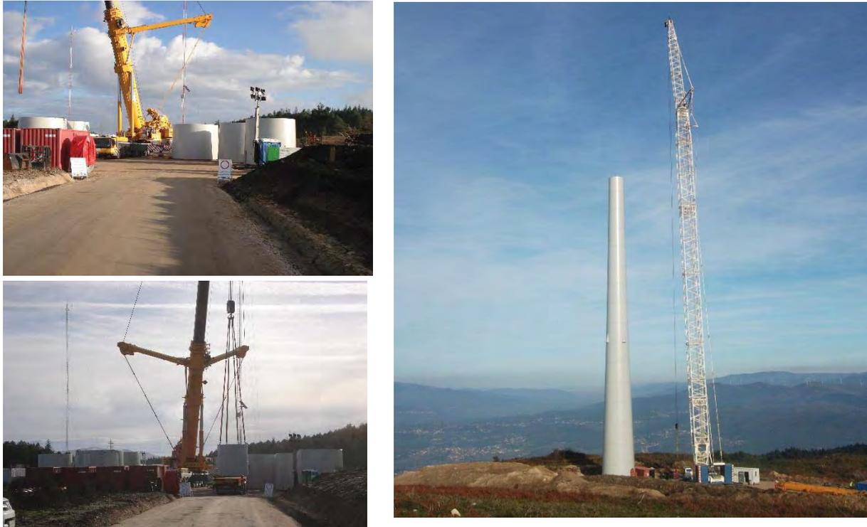
**Fotografia 10 – Montagem de uma torre de aço.**
