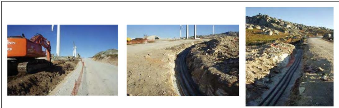
**Fotografia 7 – Abertura de vala para instalação de cabos elétricos.**
