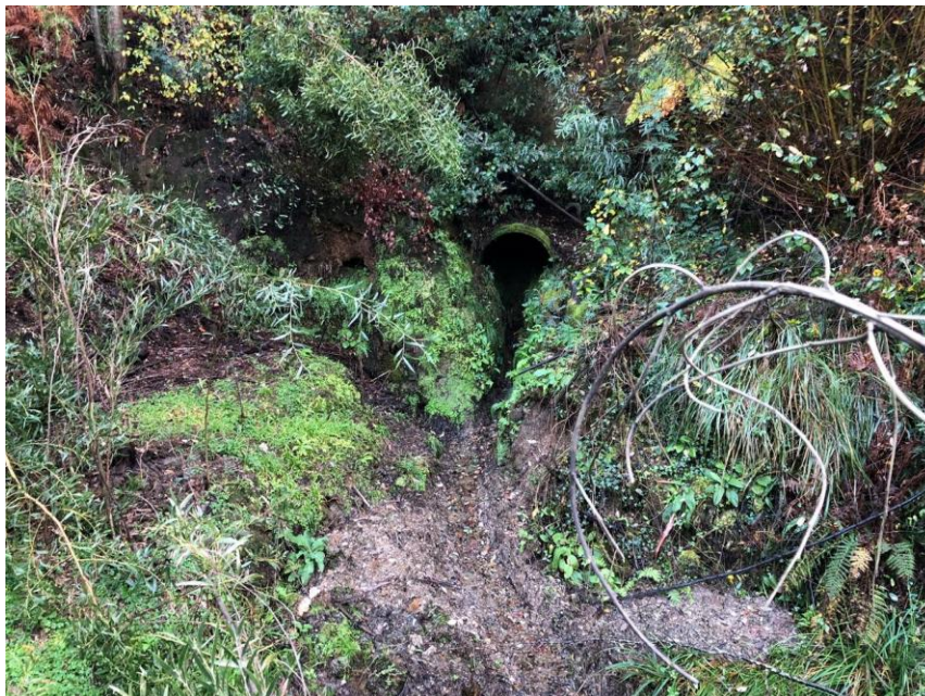
Figura 5.2 – Nascente de água
