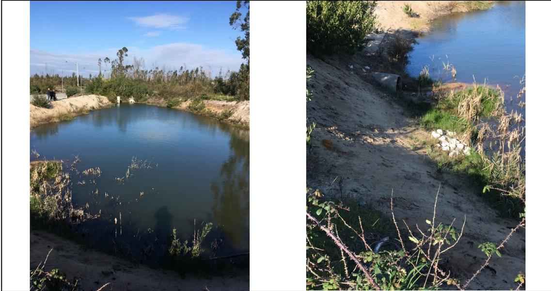
**Figura 3.9 – Lago de amortecimento das águas pluviais.**
