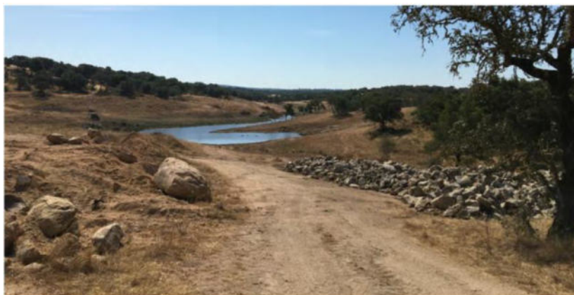
Fotografia 6 – Acesso existente até ao local de construção da Barragem.
