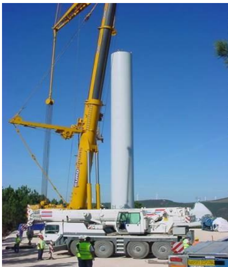
Fotografia 2.3 – Exemplo de uma plataforma para montagem do aerogerador .
