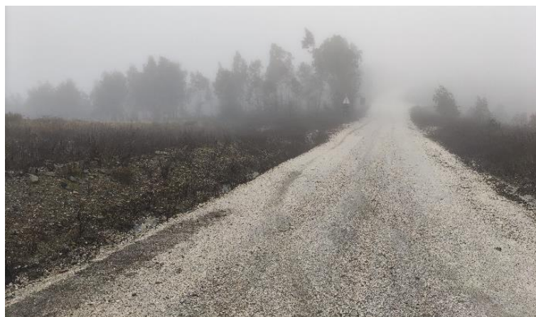
Fotografia 4.3 – Acesso do parque eólico existente.
