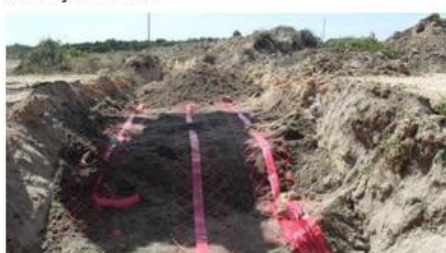
Colocação da rede de sinalização vermelha
