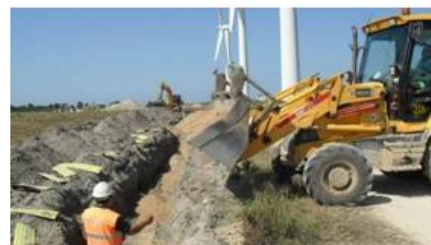
Colocação da areia na base da vala
