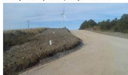
Vala de cabos após recuperação paisagística
