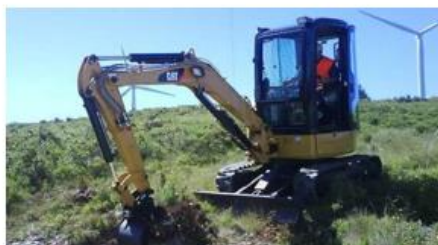
Trabalhos de escavação da vala
