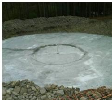
Fundação com betão de limpeza
