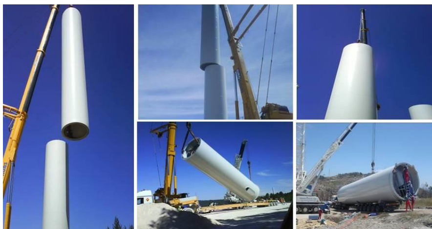
Fotografia 2.4 – Exemplo de trabalhos de montagem da torre de um aerogerador.
