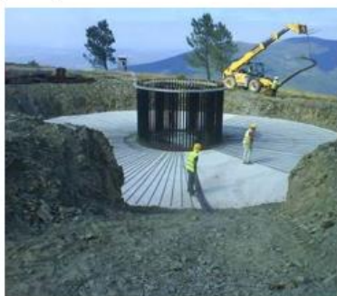
Trabalhos de armação de ferro
