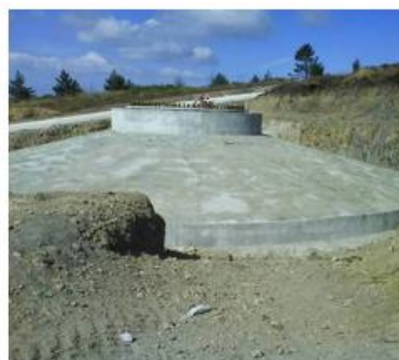
Fundação betonada e pronta para ser aterrada
