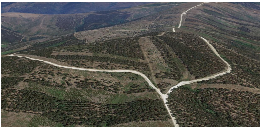
Fotografia 4.4 – Visão geral da área da topografia da área do Projeto.
