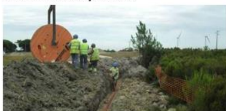
Colocação de cabo
