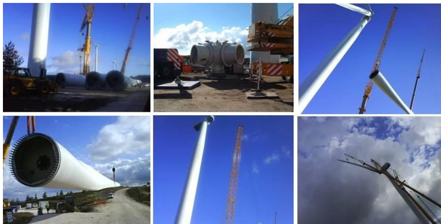
Fotografia 2.5 – Exemplo de transporte e montagem das pás de um aerogerador.
