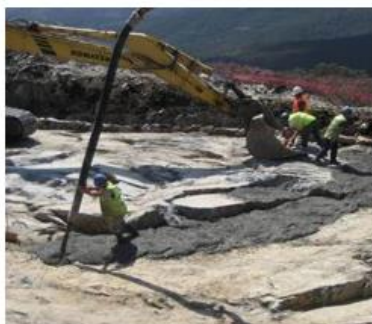
Betonagem de betão de limpeza na fundação
