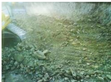
Escavação do cabouco
