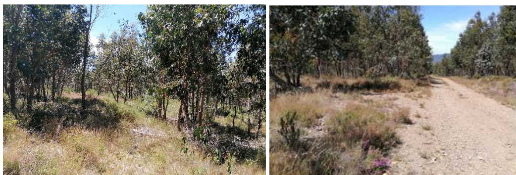
Fotografia 4.20 – Local do novo aerogerador e acessos a melhorar.
