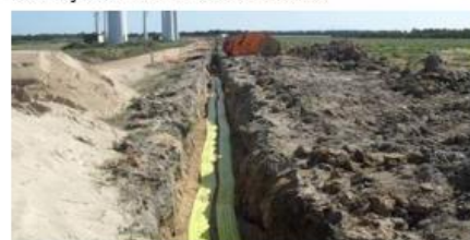
Colocação das lajetas de proteção mecânica
